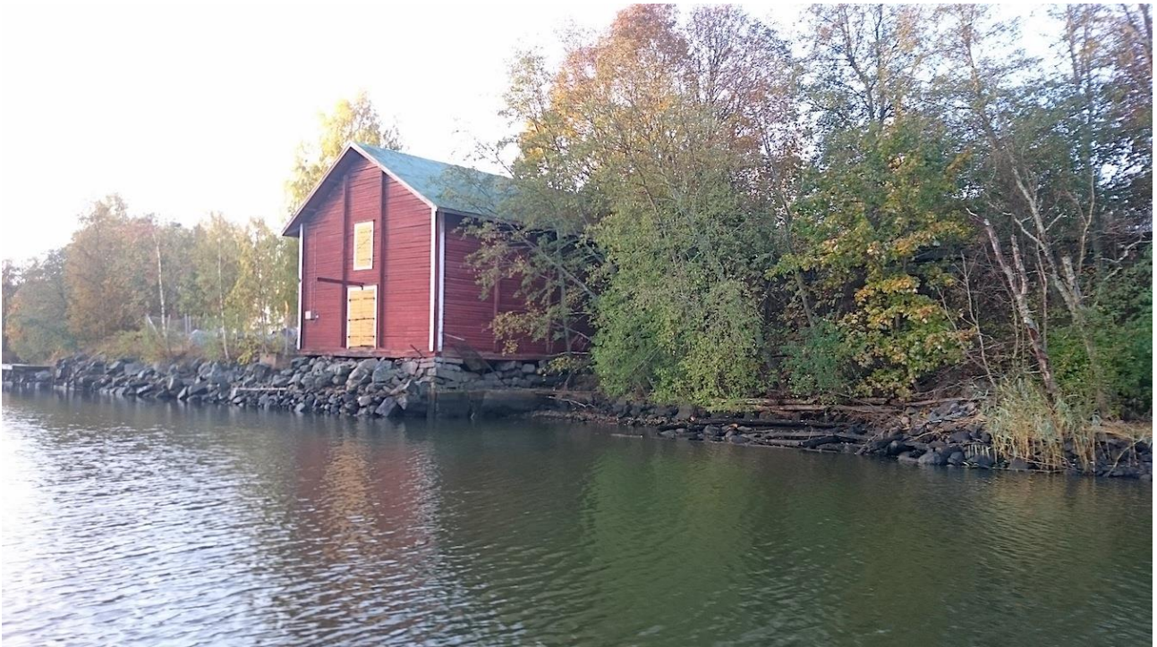
Kuva 25. Mansikkasaaren makasiini kuvattuna lounaaseen. Makasiinin oikealla puolella rannassa on hirsiarakkurakenteita ja vasemmalla ranta on pinnan yläpuolella täyttölouhikkoa.
