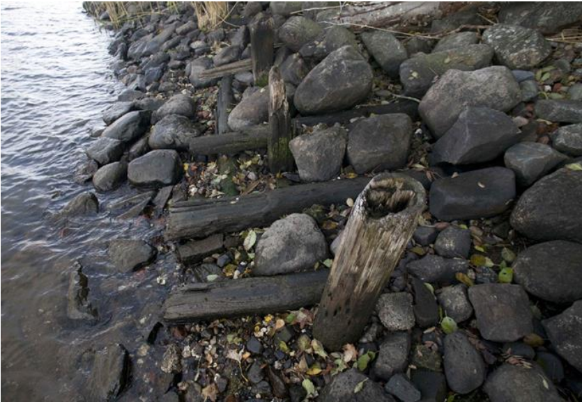
Kuva 30. Pystypaalut ja kivikon sisään jatkuvat hirret. Hirsiarkkurakenne sijaitsee kuvan yläreunan ulkopuolella. Kuvaussuunta on etelään.
