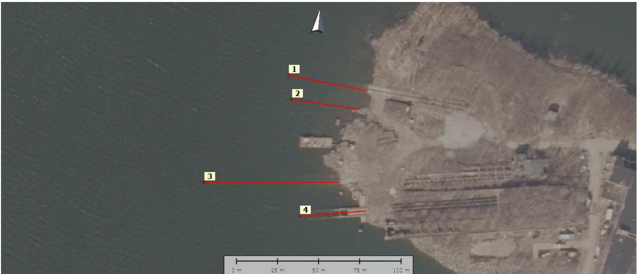
Kuva 16. Ilmakuva telakan ympäristöstä ja raiteiden sijainti vedessä.
