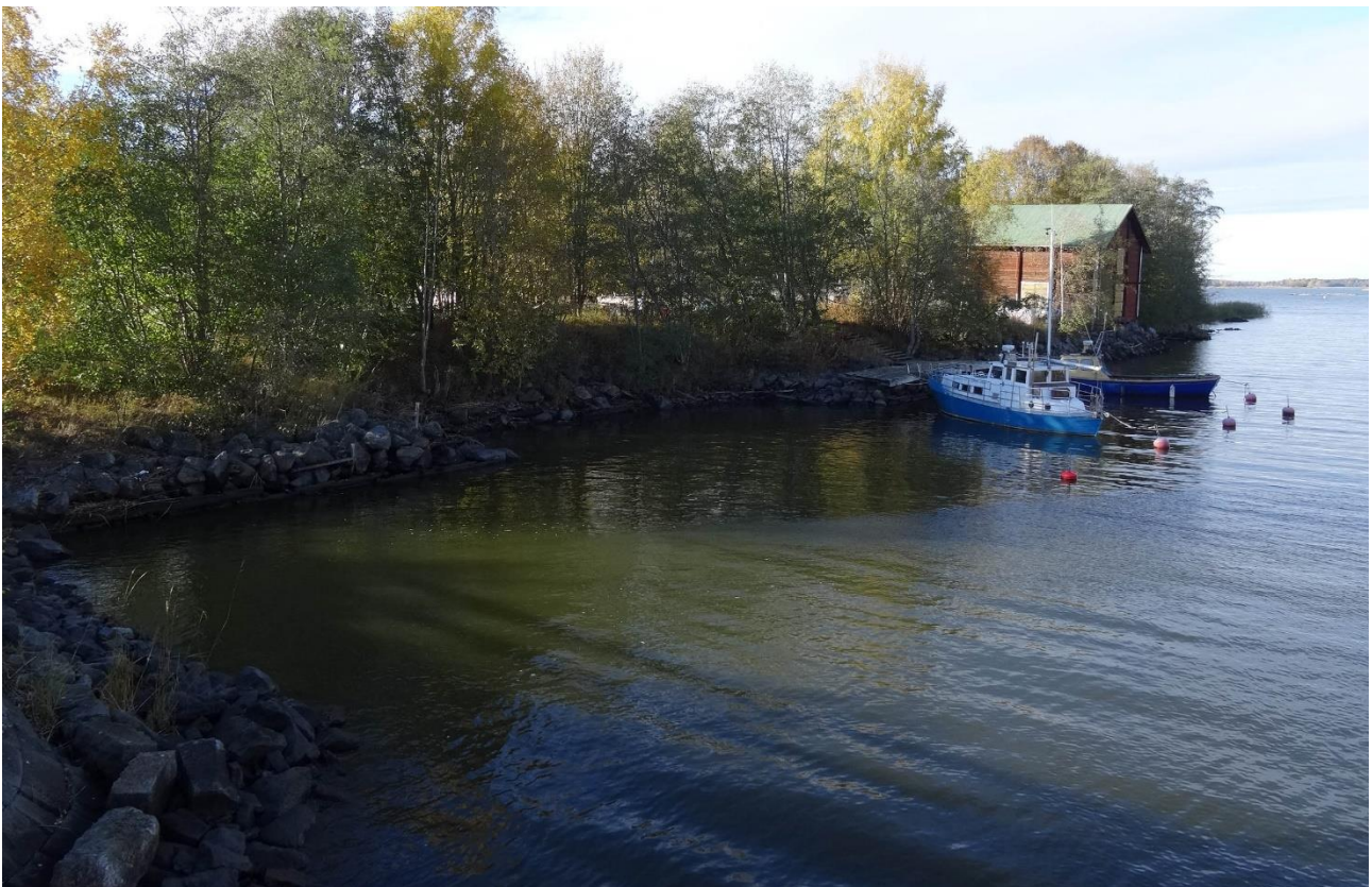
Kuva 19. Kuva on otettu Mansikkasaaren johtavalta sillalta luoteeseen. Kuvan vasemmassa alareunassa näkyy sillan perustukseen liittyvää rakennetta. Itse saaren rannassa voidaan havaita hirsiarquille perustettua rantaa sekä arkkuperustainen laituri, jossa veneet ovat kiinni. Rantaan muodostuu suorakaiteenmuotoisia ulkonemia. Taustalla näkyy makasiini, jonka pohjoispuolella hirsiarquurakenteet jatkuvat.
