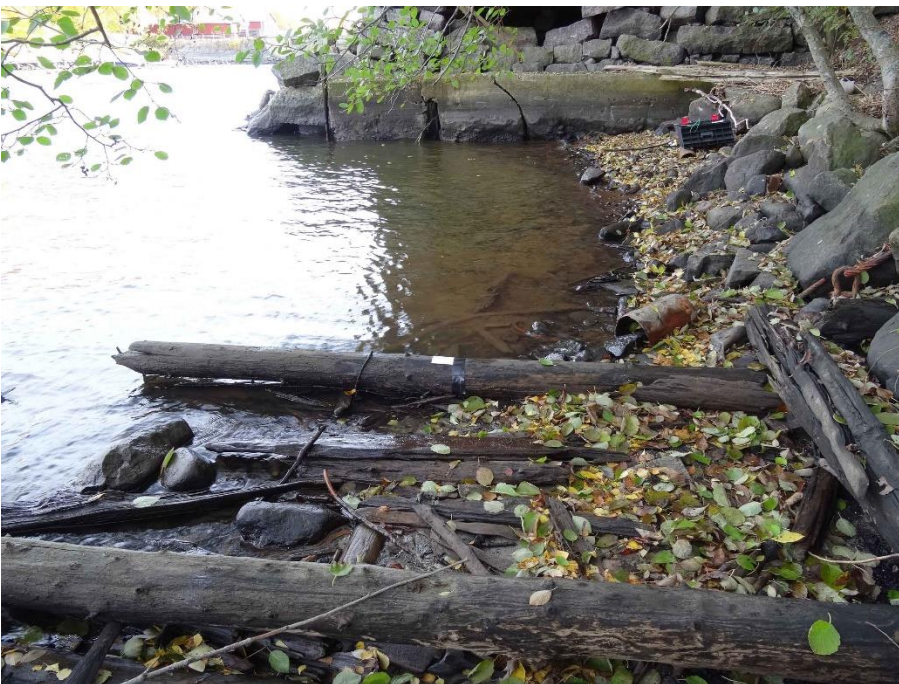
Kuva 33. Näytteen 3 sijainti hirsiaakkurakenteessa ennen näytteenottoa. Näyte on merkitty teipillä ja valkoisella kyltillä kuvassa poikittain olevaan hirteeseen. Kuvaussuunta on etelään, kohti makasiinirakennusta.
