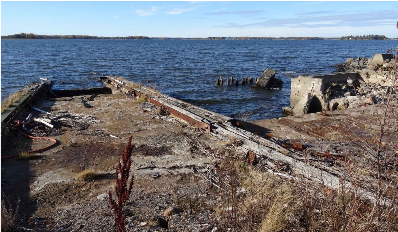
Kuva 4. Telakan ranta-alue on täynnä osittain purettuja betonirakenteita. Kuvaussuunta on luoteeseen.
