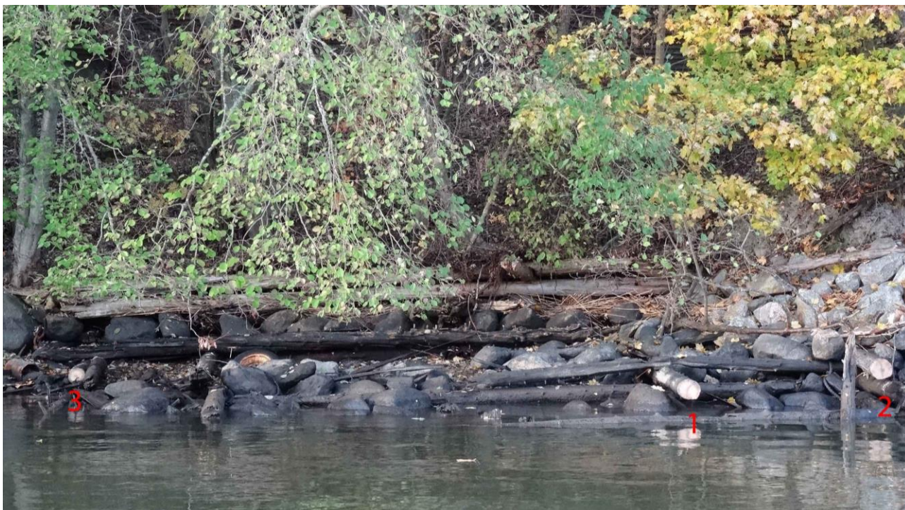
Kuva 36. Hirsiarkkurakenne näytteenoton jälkeen. Näytteiden paikat on numeroitu kuvaan punaisella. Arkku jatkuu rantapenkan sisään ja vesirajan yläpuolella hirret ovat kuivuneita ja lahonneita. Kuvaussuunta on länteen.
