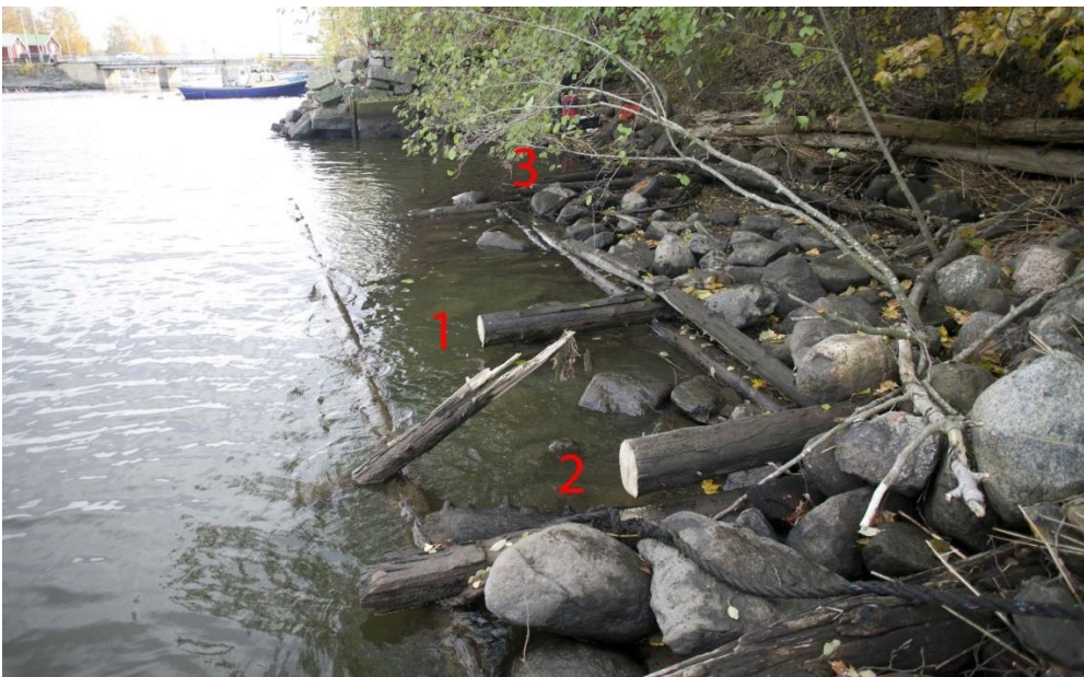
Kuva 35. Hirsarkkurakenne näytteenoton jälkeen. Näytteiden paikat on numeroitu kuvaan punaisella. Kuvassa näkyy hyvin arkun etureunan hirs vedenpinnassa. Kuvaussuunta on etelään.
