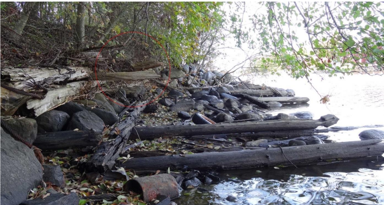
Kuva 27. Hirsiarokun veden yläpuoliset osat kuvassa vasemmalla ovat kuivuneet ja lahonneet. Ne jatkuvat rantapenkan sisään. Kuvaan on ympyröity penkasta törröttävät hirret. Kuvaussuunta on pohjoiseen.
