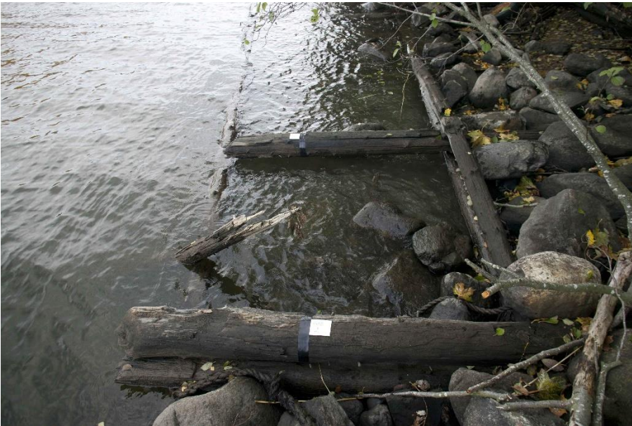
Kuva 32. Näytteiden 1 ja 2 sijainti hirsiaakkurakenteessa ennen näytteenottoa. Näytteet on merkitty teipillä ja valkoisella kylteillä kuvassa poikittain oleviin hirsiiin. Etualalla on näytehirsi numero 2 ja taaempana näytehirsi numero 1. Kuvaussuunta on etelään, kohti makasiinirakennusta.
