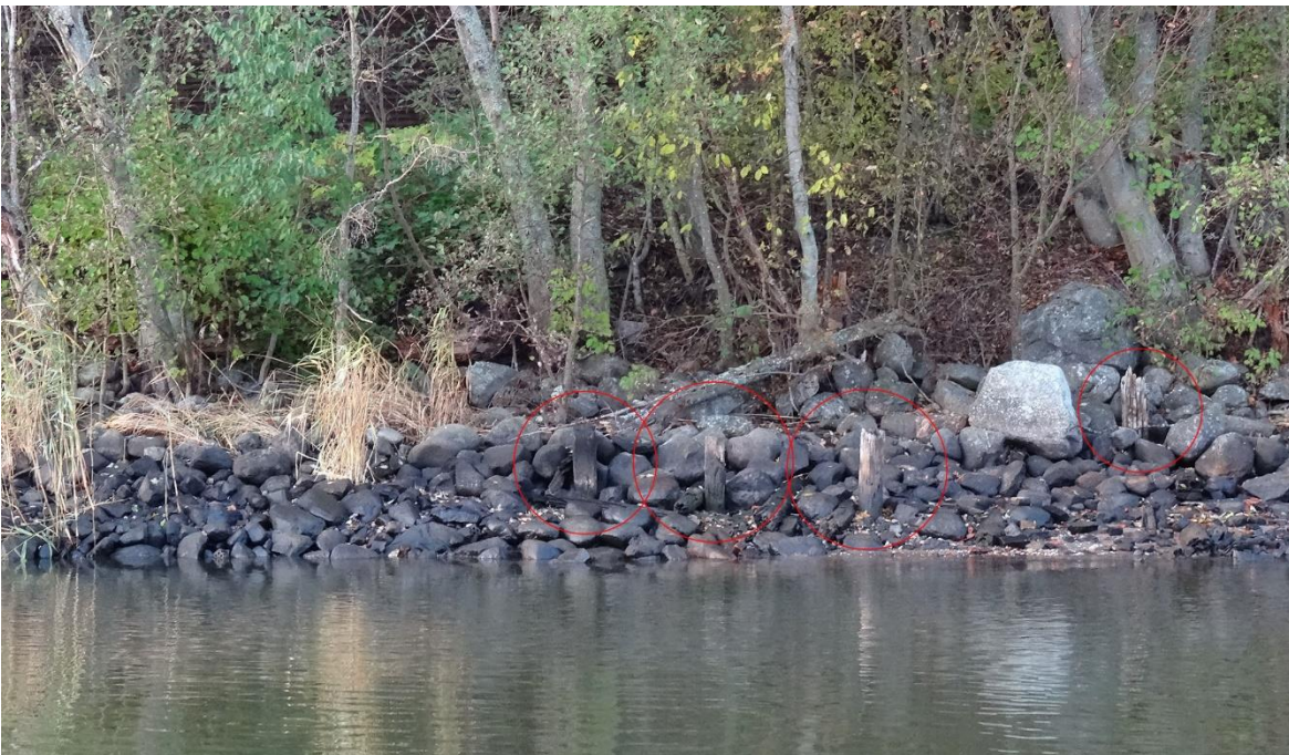
Kuva 32. Hirsiarkkurakenne sijaitsee kuvan ulkopuolella vasemmalla. Rannassa on näkyvissä neljä pystypaalua, joiden alla kivikon sisällä on rantapenkan sisälle jatkuvia hirsiiä. Paalut on ympyröity kuvaan punaisella. Kuvaussuunta on länteen.
