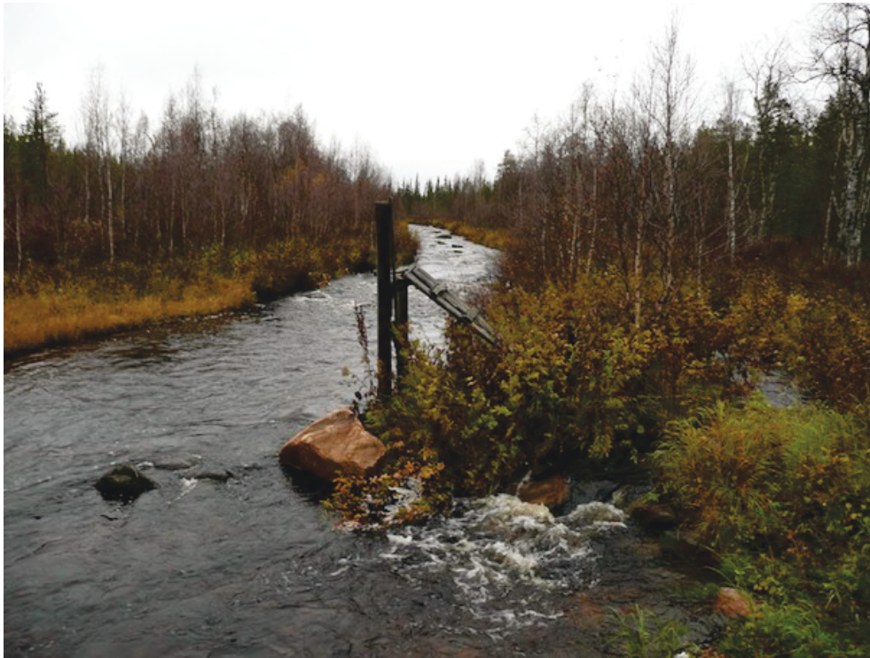
Itärannalla on jäljellä enemmän sillanrakenteita. Kuvattu pohjoiseen.
