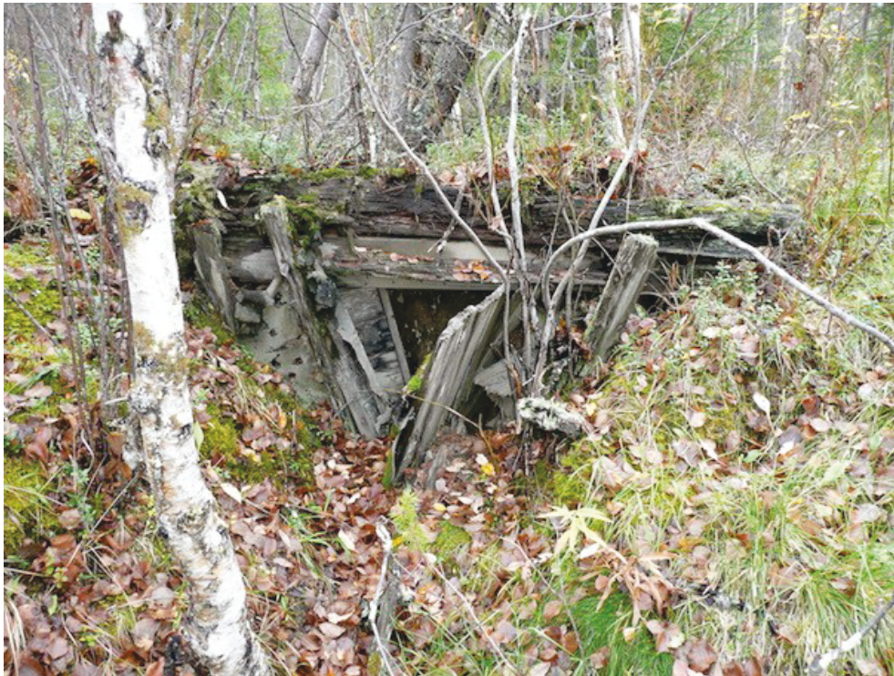
Lähikuva kellarin oviaukosta. Kuvattu itään.
