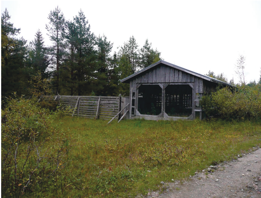
Rakennus erotusaidan vieressä. Kuvattu luoteesta.
