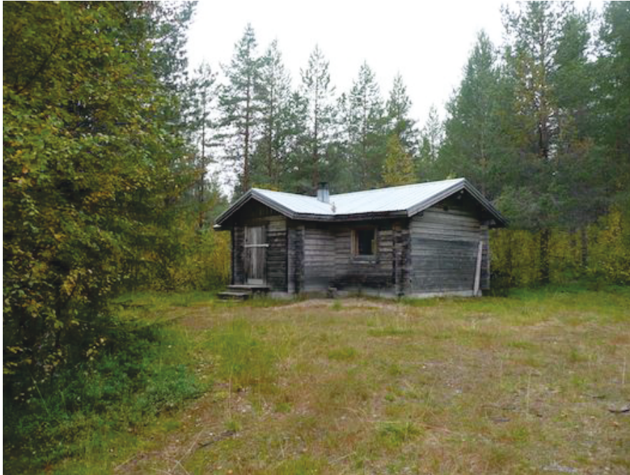
Kämppä kuvattuna koillisesta.
