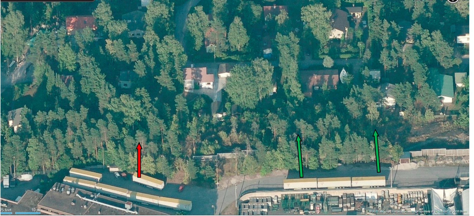
Vuonnisenpolun pohjoisosa ennen rakennustöitä. Asemat 7 ja 8. Kuva: Bing maps. Kuvausvuosi epäselvä.
