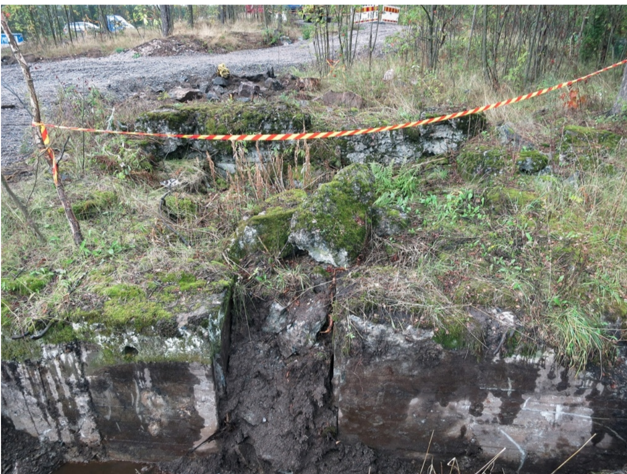
Asema 7, eteläinen hauta. Suojahuone, jonka sisällä on hajotetun katon betonilohkareita. Kuvaussuunta N. 28.8.2014.
