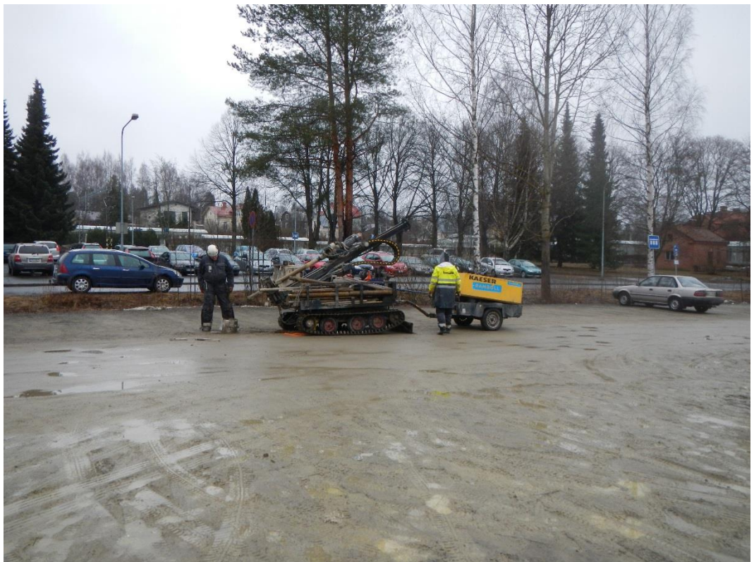
Kuva 4. Kairausvaunu miehistöineen valmistautumassa kairaukseen aseman parkkipaikalla pisteen 12 kohdalla. Kuvassa Jarno Moilanen ja Juuso Karikorpi.
