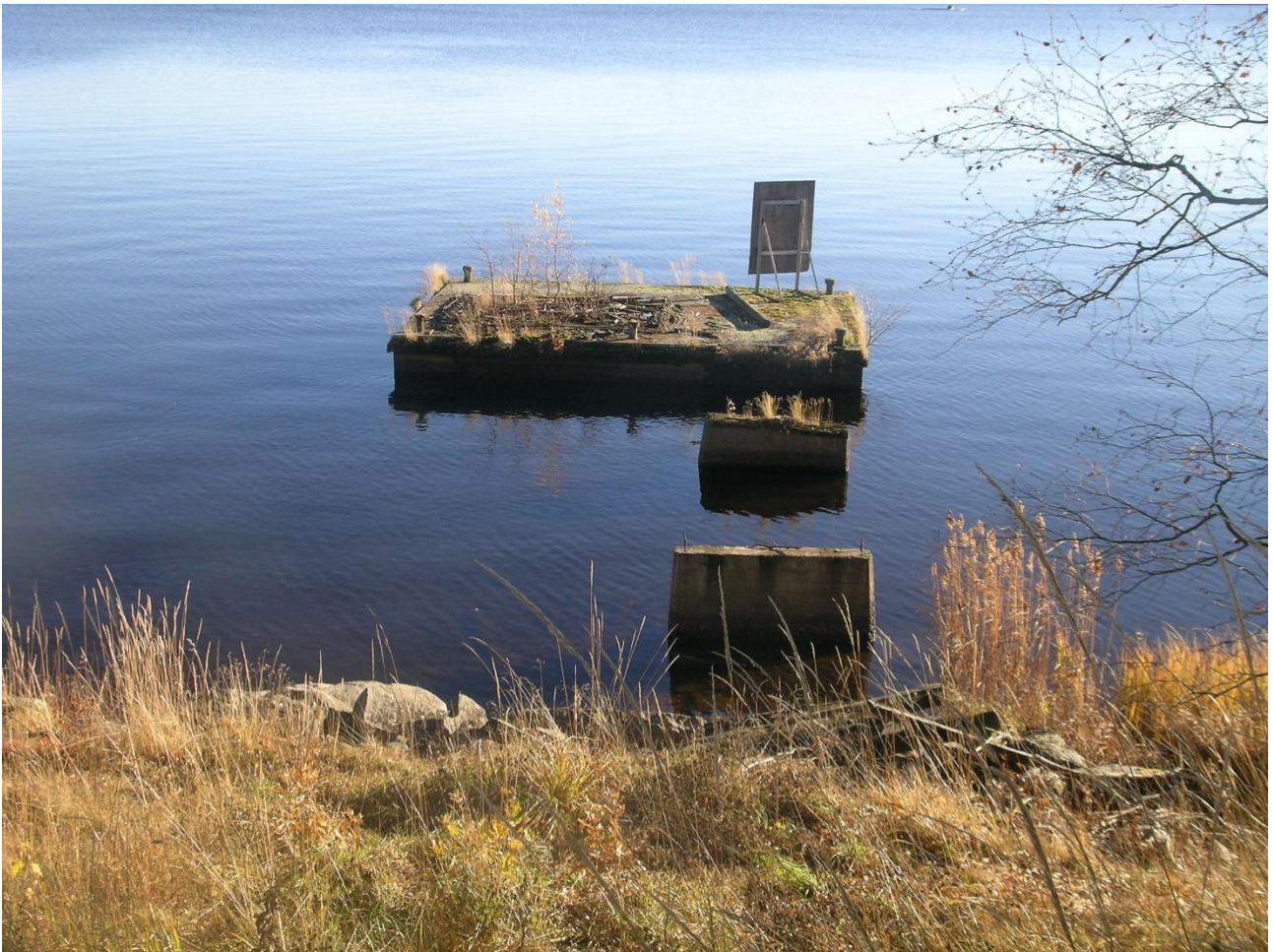
Kuva 12. Betonilaiturin raunio nähtynä kaakkoon. KYY 167: 34.
