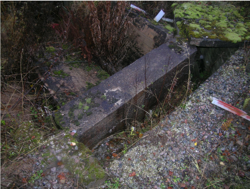
Kuva 3. Sepelikentän betonirakenteita. KY 167: 16.
