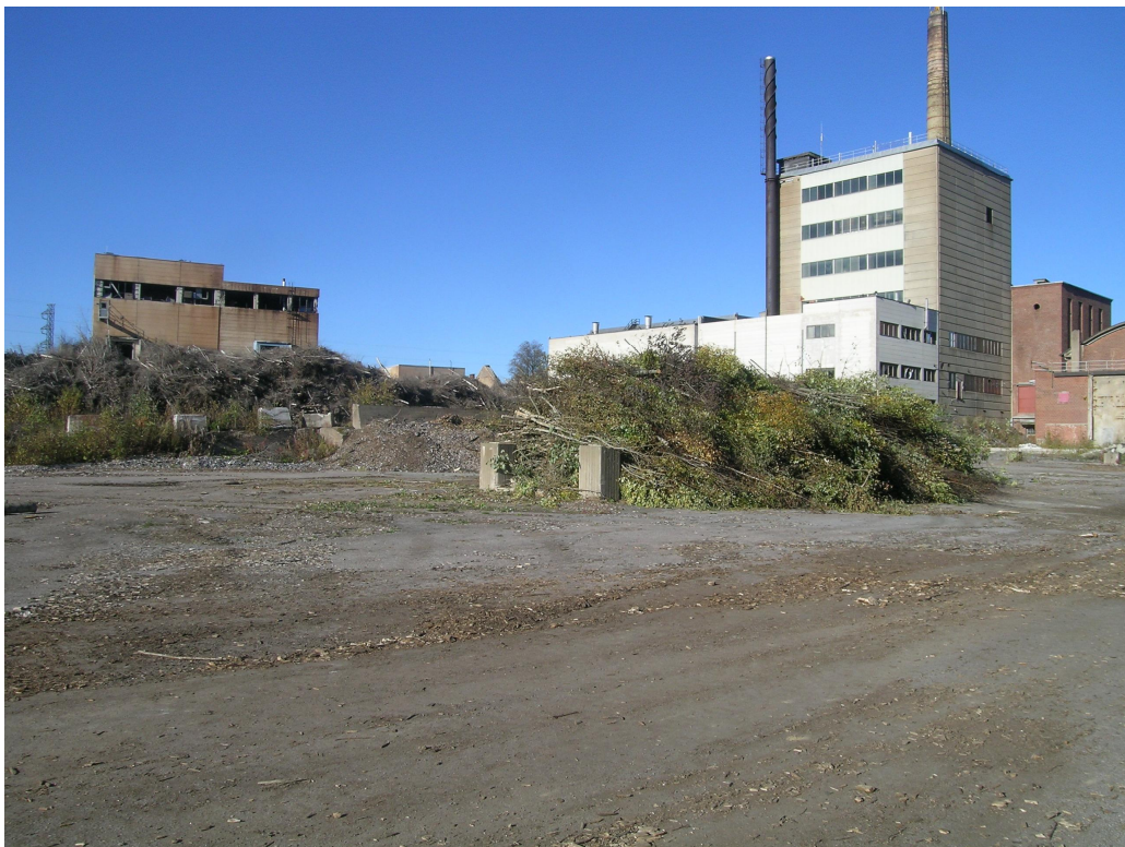
Kuva 1. Tehdasrakennuksia ja tuoreita hakkuujättepinoja. Etualalla näkyvä kenttä on vanhaa ratapihaa, josta kiskot on purettu. KYY 167: 1.
