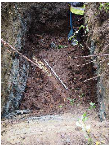
Kuva 16. Turpeen pinnasta tunnistettiin muutamia tuoreena näköisiä puunrunkoja, joissa ei havaittu työstön jälkiä.
