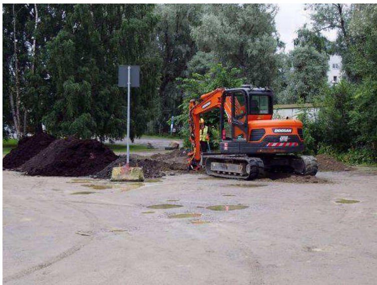
Kuva 1. Koekaivaus toteutettiin pitkälti konekaivuuna.
