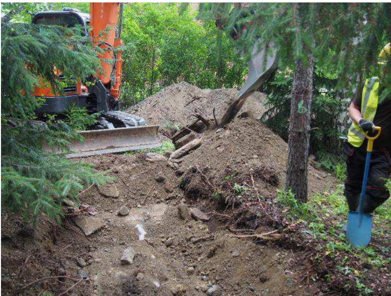
Kuva 8. Raudoitettu betonirakenne poiskaivettuna koeojassa 3.
