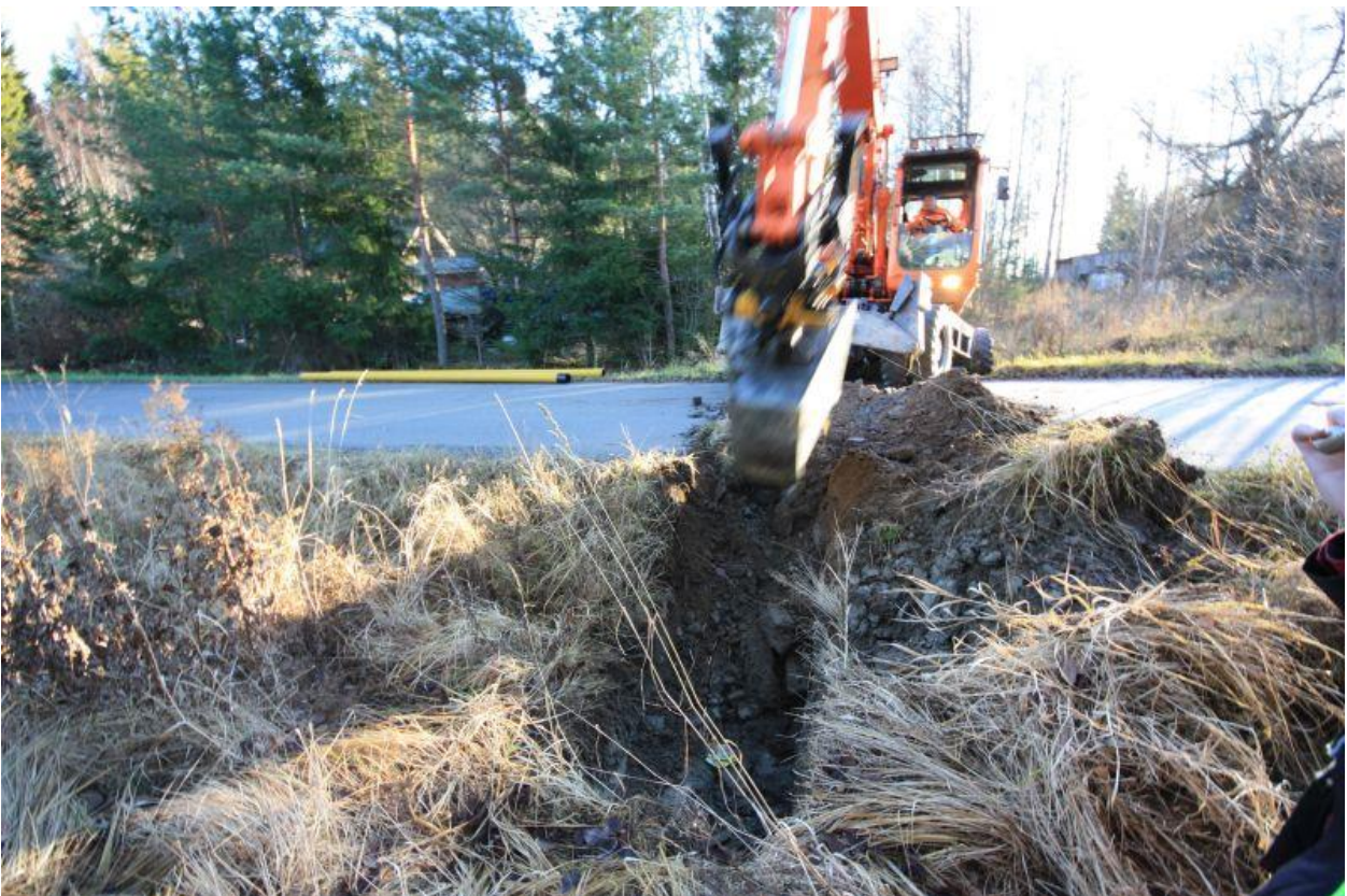
AKDG4677:20 Heinoontien katkaisun valvonta Heinoontie 312 kohdalla. Kaivannon länsipää. Kuvattu länsiluoteesta 3.11.2015. Kuva Esa Mikkola, Arkeologiset kenttäpalvelut
