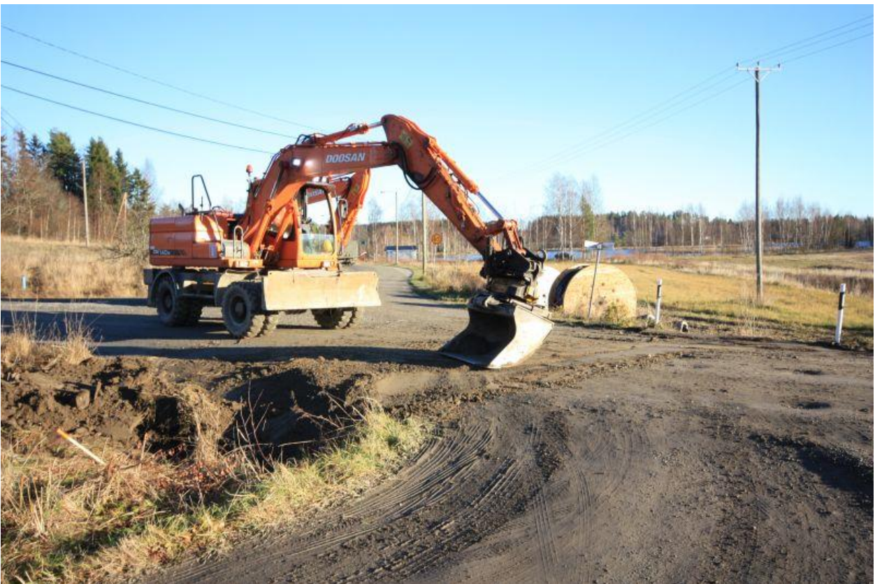
AKDG4677:17. Heinoontien katkaisun valvonta Heinoontie 418 kohdalla. Kaivanto täytettynä. Kuvattu lounaasta 3.11.2015. Kuva Esa Mikkola, Arkeologiset kenttäpalvelut
