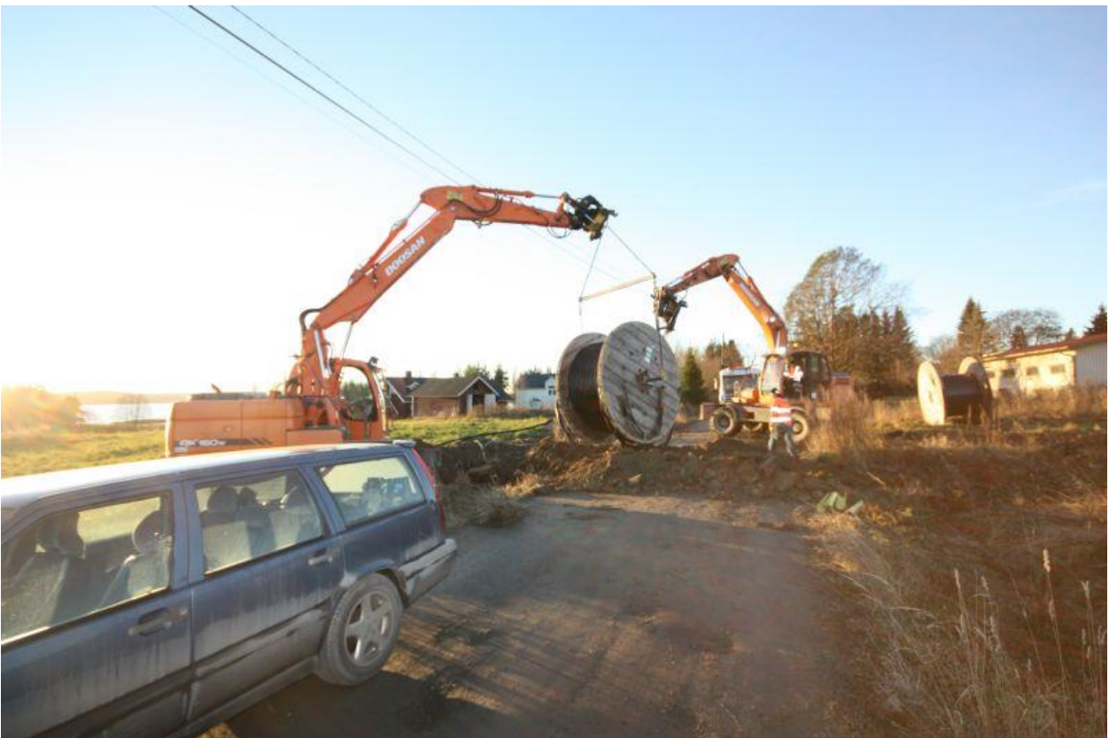
AKDG4677:6. Heinoontien katkaisun valvonta Heinoontie 480 kohdalla. Kaapelin laittoa. Kuvattu koillisesta 3.11.2015. Kuva Esa Mikkola, Arkeologiset kenttäpalvelut
