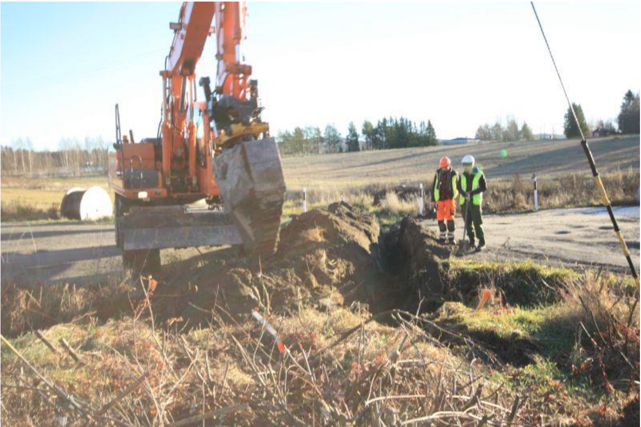
AKDG4677:16. Heinoontien katkaisun valvonta Heinoontie 418 kohdalla. Kaivannon täyttöä. Kuvassa Olli Eranti ja Petri Suomala Kuvattu lännestä.
