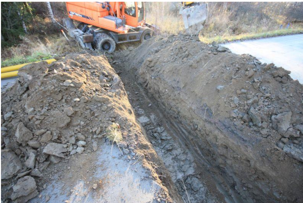
AKDG4677:21 Heinoontien katkaisun valvonta Heinoontie 312 kohdalla. Tien poikki menevä kaivanto. Kuvattu luoteesta 3.11.2015. Kuva Esa Mikkola, Arkeologiset kenttäpalvelut
