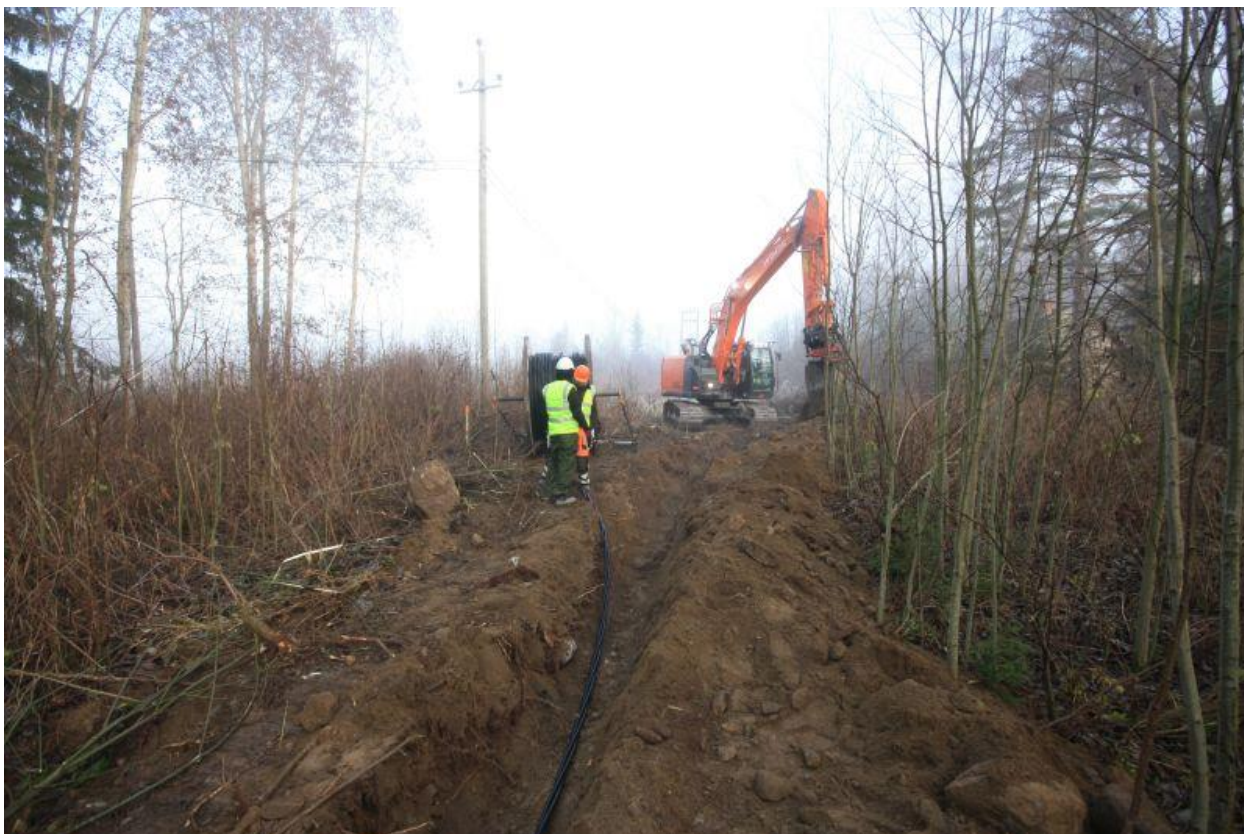
AKDG4679:18. Kaapelikaivanto hiilimiilun/tervahaudan koillispuolella. Kuvassa Petri Suomala ja Olli Eranti. Kuvattu lounaasta 5.11.2015. Kuva Esa Mikkola, Arkeologiset kenttäpalvelut
