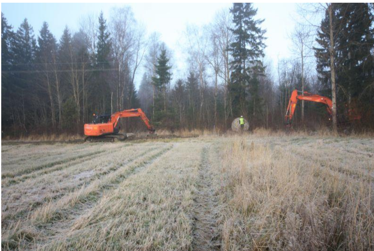
AKDG4679:12. Kaapelointityömaa valvonta-alueen lounaispuolella. Kuvattu kaakosta 5.11.2015. Kuva Esa Mikkola, Arkeologiset kenttäpalvelut
