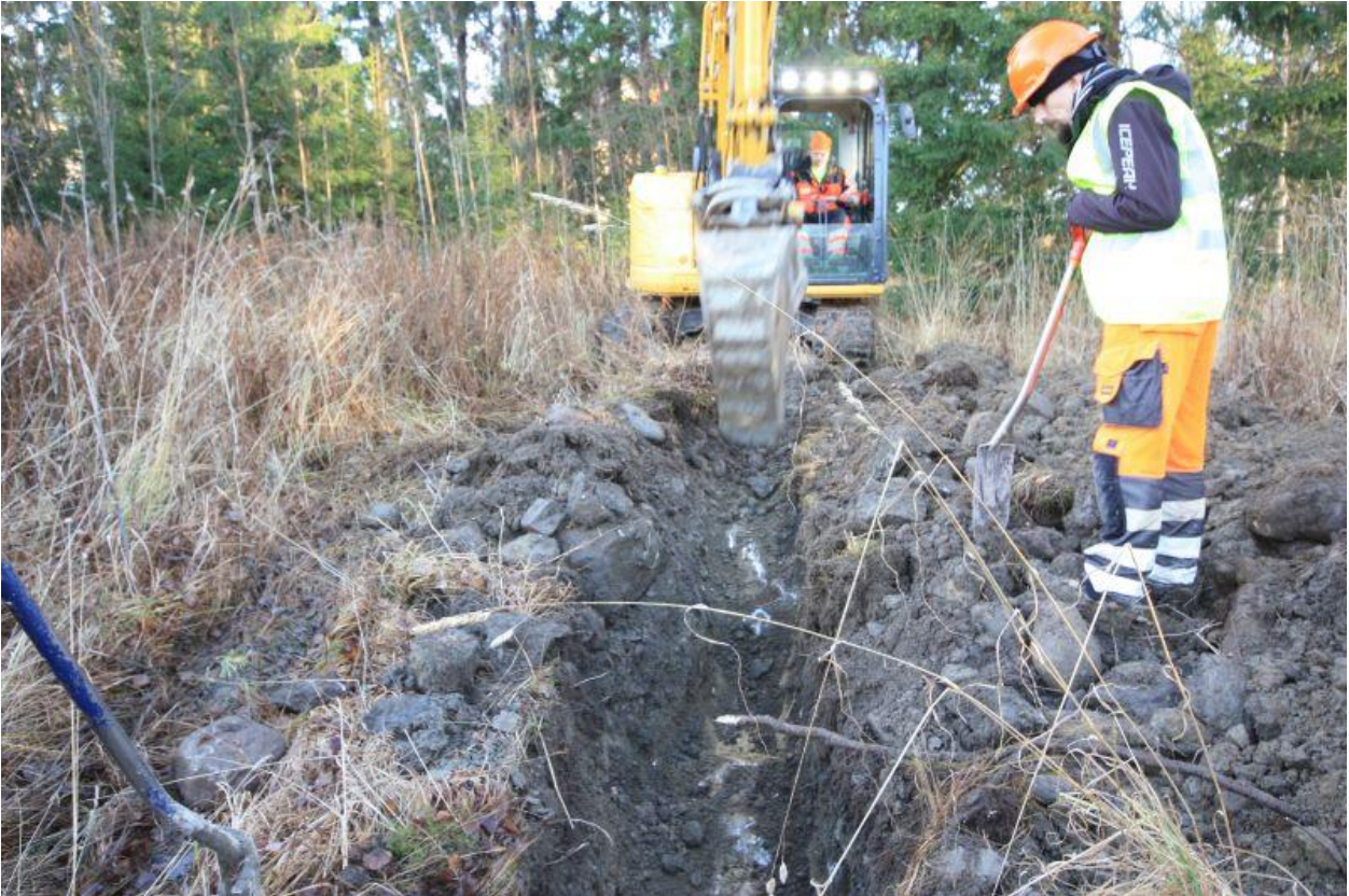
AKDG4665:14. Konekaivun valvonta käynnissä kaapelilinjalla. Kallio tulee esille savisen muokkauskerroksen alta. Kuvassa Petri Suomala. Kuvattu lännestä 4.11.2015. Kuva Esa Mikkola, Arkeologiset kenttäpalvelut
