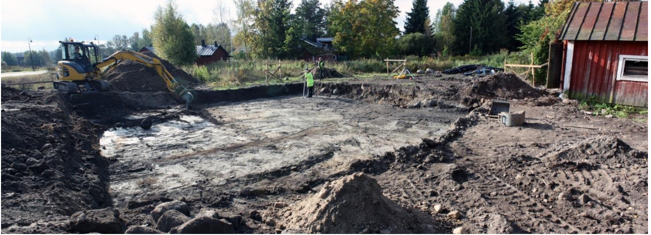
Kuva 13. Valvottu kaivanto, kuvattu koillisesta. AKDG 4689:11
