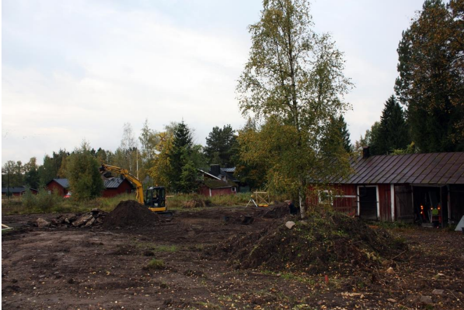
Kuva 3. Uuden asuinrakennuksen rakennuspaikka, kuvattu pohjoiskoillisesta. AKDG 4689:3
