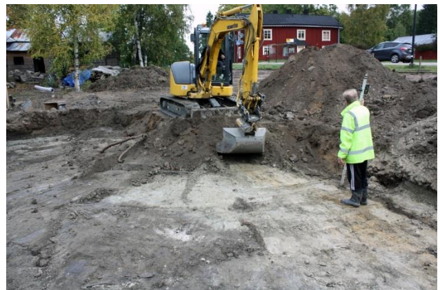
Kuva 6. Maata poistetaan ohuina kerroksina tulevan asuinrakennuksen kohdalta, kuvattu etelästä. AKDG 4689:6
