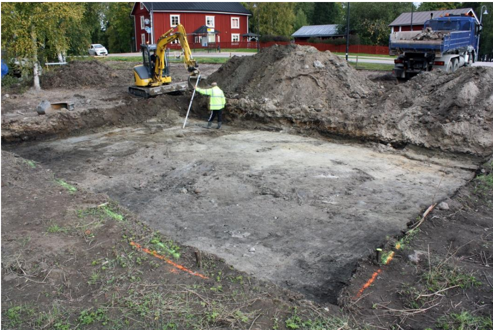
Kuva 12. Maata poistettu noin puolelta tulevan asuinrakennuksen pinta-alalta, kuvattu lounaasta. AKDG 4689:9
