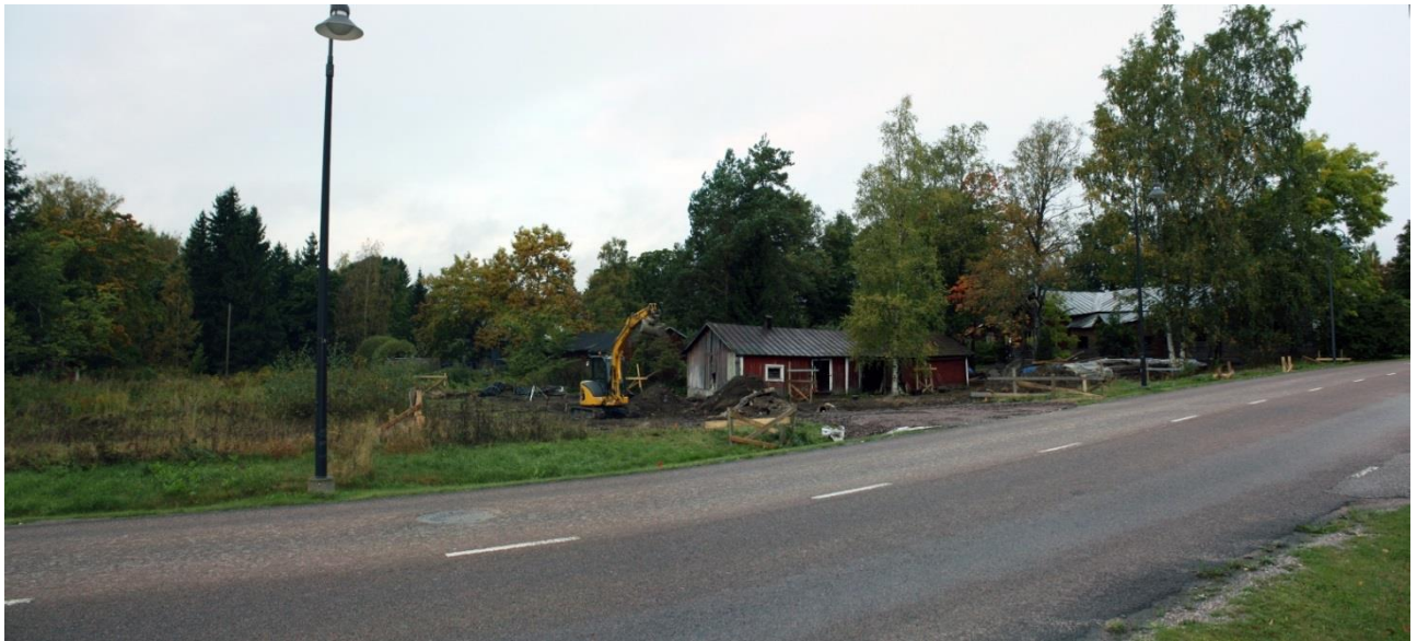
Kuva 1. Näkymä kohti tutkimuskohdetta, kuvattu kaakosta. AKDG 4689:1
