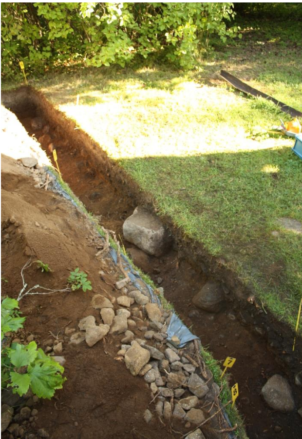
Kuva 25. Kaivausojan pohjoisosa kaivettu pohjaan, kuvattu lounaasta. AKDG 4664:30
