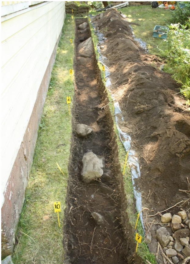
Kuva 18. Kaivausojan eteläosa tasossa 4, kuvattu koilli- sesta. AKDG 4664:22
