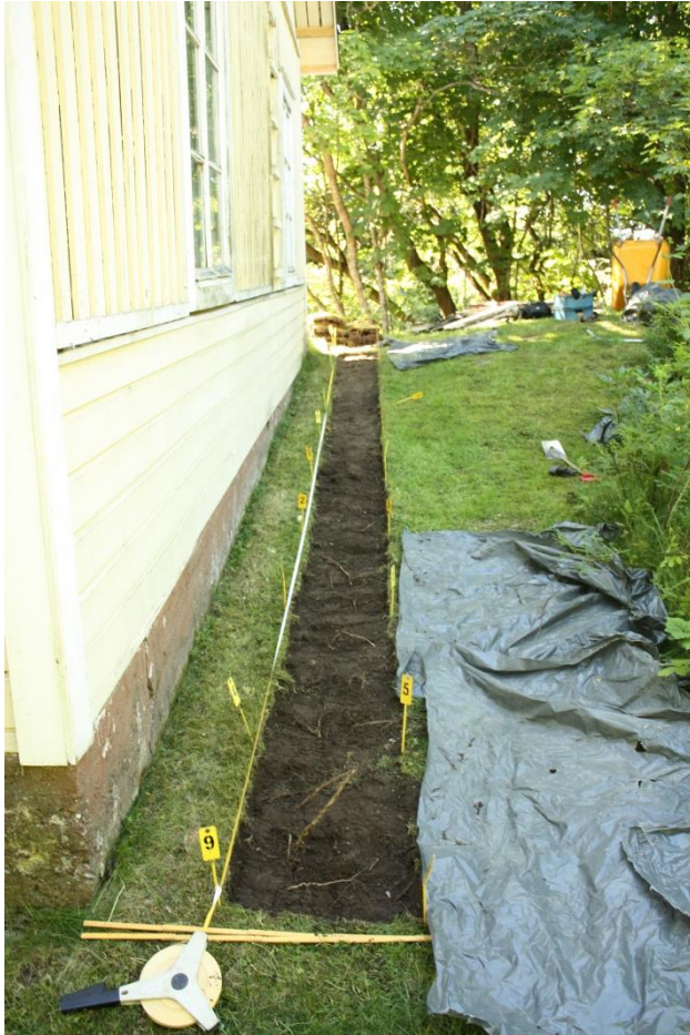
Kuva 12. Kaivausojan eteläosa turpeen poiston jälkeen, kuvattu koillisesta. AKDG 4664:12
