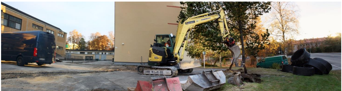
Kuva 1. Kirkkomäen kerrostalon piha, johon on aikomus rakentaa maalämpöjärjestelmä. Kuvattu lounaasta. AKDG 4691:1
