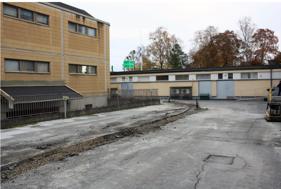
Kuva 4. Tulevan maalämpöpöjärjestelmän pohjoisosa, josta asfalttia on poistettu tulevan siirto-putkilinjan kohdalta. Kuvattu etelästä. AKDG 4691:4
