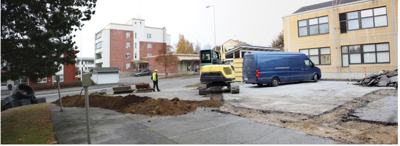
Kuva 2. Tulevan maalämpöpöjärjestelmän eteläosa, josta asfalttia on poistettu tulevan siirto-putkilinjan kohdalta. Kuvattu idästä. AKDG 4691:2
