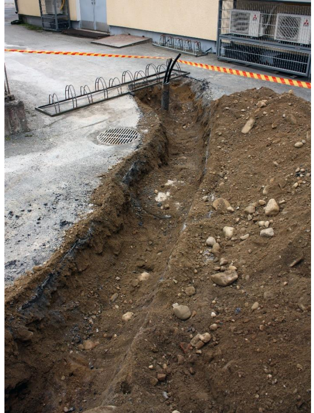
Kuva 10. Putkiojan pohjoisosa, jossa asfaltin alla oli sekoittunutta hiekkaa, kuvattu lounaasta. AKDG 4691:9
