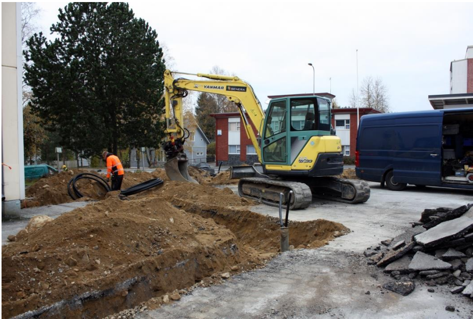
Kuva 7. Kaivettuun putkiojaan asennetaan maalämpöjärjestelmän siirtoputkistoa, kuvattu pohjoisesta. AKDG 4691:11
