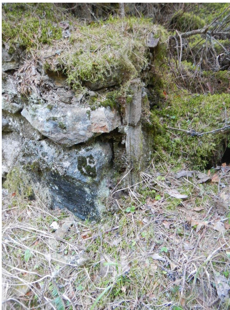
Kuva 10. Oviaukkoa on vahvistettu sementillä.
