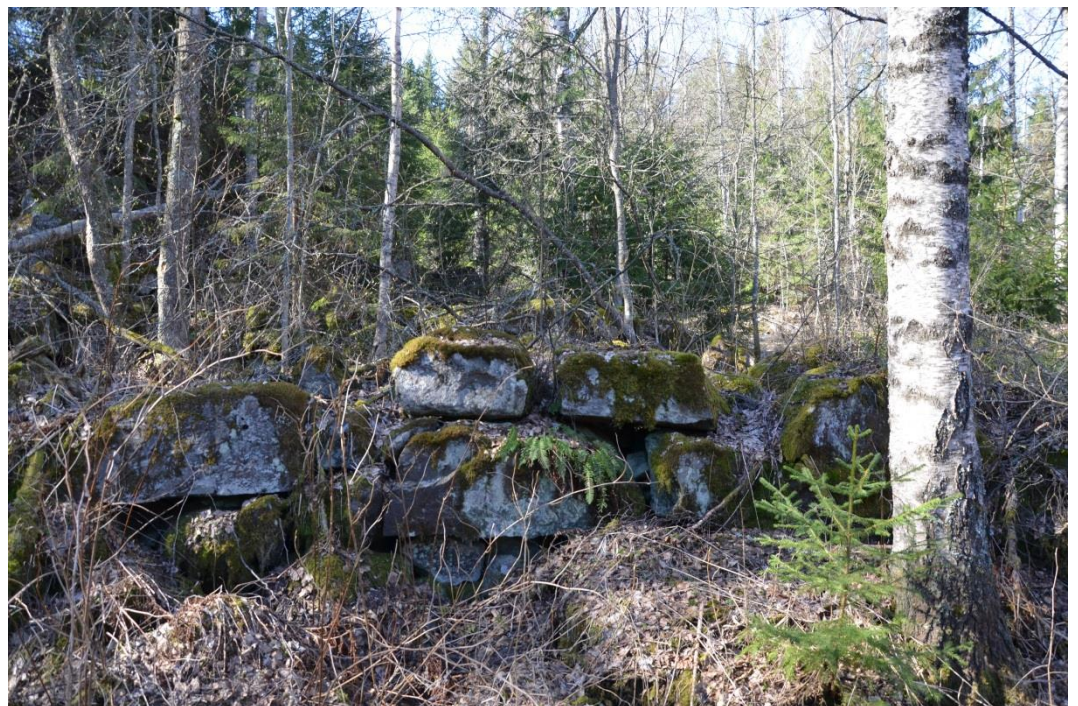
Kuva 12. Myllyn lohkokivistä rakennettua vesikanavaa koordinaattipisteen osoittamassa kohdassa.
