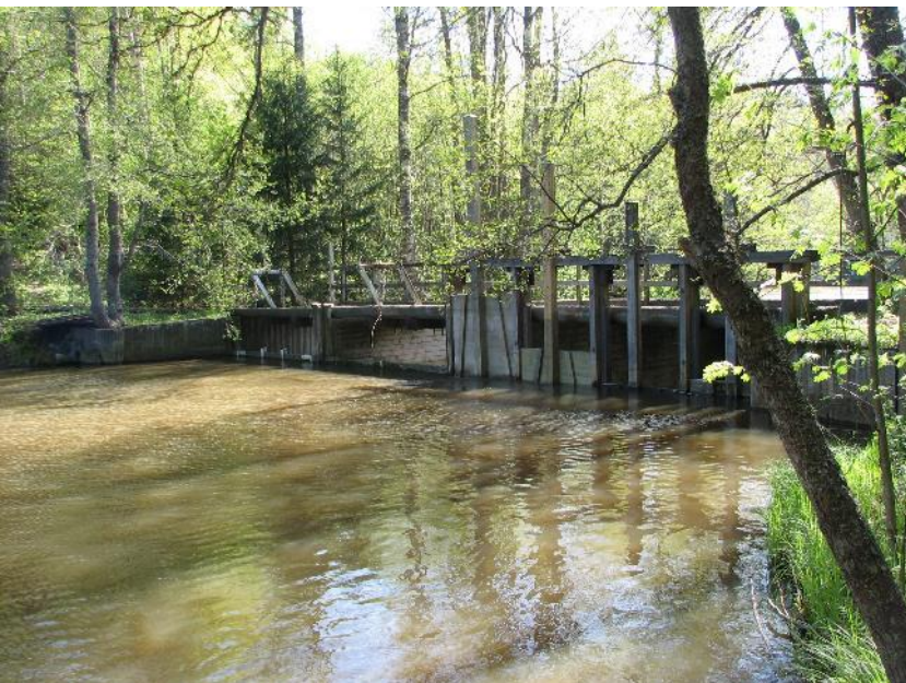
Kuva 19. Hålldamin padon raken- teita 25.5.2015.
