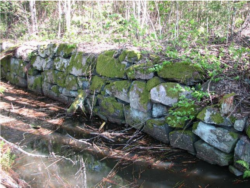
Kuva 20. Hålldamin sulkukana- van rakenteita 25.5.2015.
