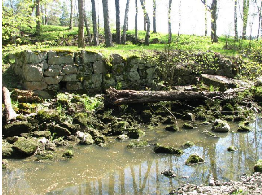
Kuva 12. Joen rannassa kohoaa masuunin perustuksiin kuuluva lohkotuista luonnonkivistä tehty kivimuuri.
