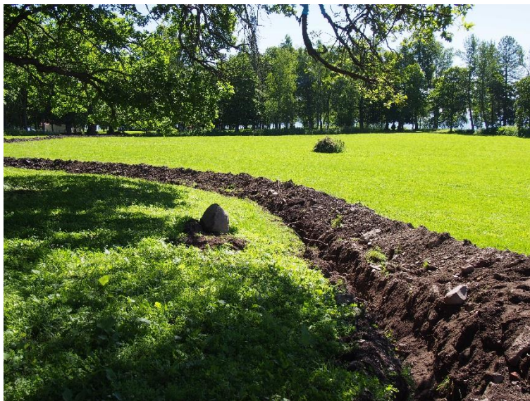
Kuva 13. Koetutkimuksen yhteydessä sähkökaapelille etsittiin uusi linjaus peltoalueelta.
