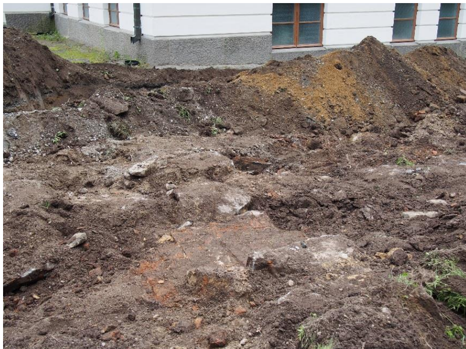
Kuva 7. Tiiliperustaisen kasvihuoneen perustuksen jäännöksiä paljastui 10 - 30 cm syvyydestä päärakennuksen luoteispuolella.
