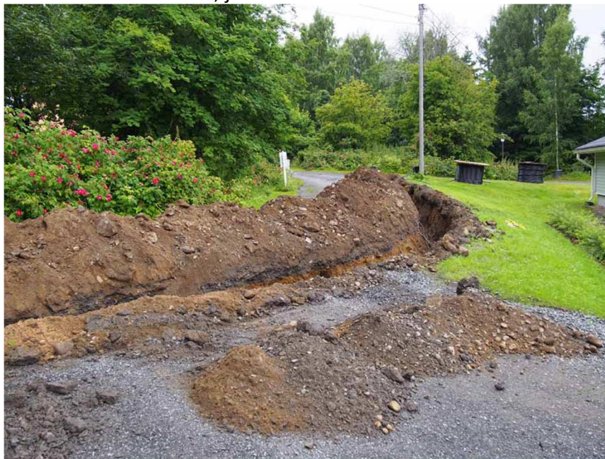
Kuva 11. Maakaapelilinjaus 2a Hakuninkujan laidassa. Kuvattu kaakosta. (Kuva: Vesilahti Kirkonkylä 2015: 9)
