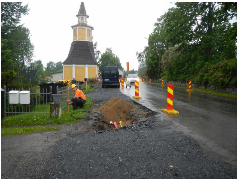
Kuva 4. Kevyenliikenteenväylän rakennustyömaa suurin piirtein paalulta 2000 itään. Maannos kirkon edustalla oli pitkälti sekoittunutta Rautialantien 1980-luvulla tehtyjen parannusten johdosta. Kuvattu idästä. (Kuva: Vesilahti Kirkonkylä 2015: 2)
