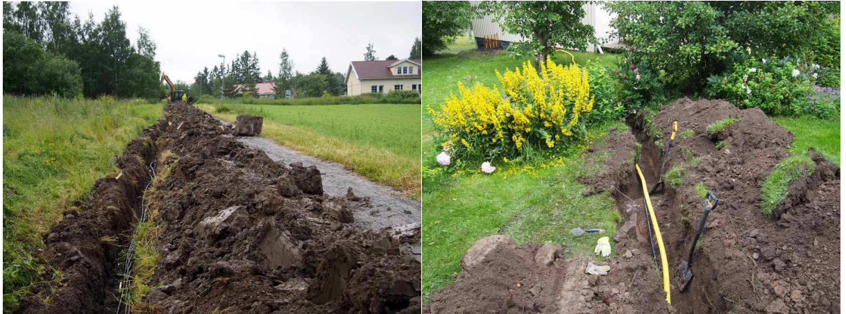
Kuva 14 (vasen). Maakaapelikaivanto linjauksella 4, kevyenliikenteenväylän vieressä. Kuvattu pohjoisesta. (Kuva: Vesilahti Kirkonkylä 2015: 12)
