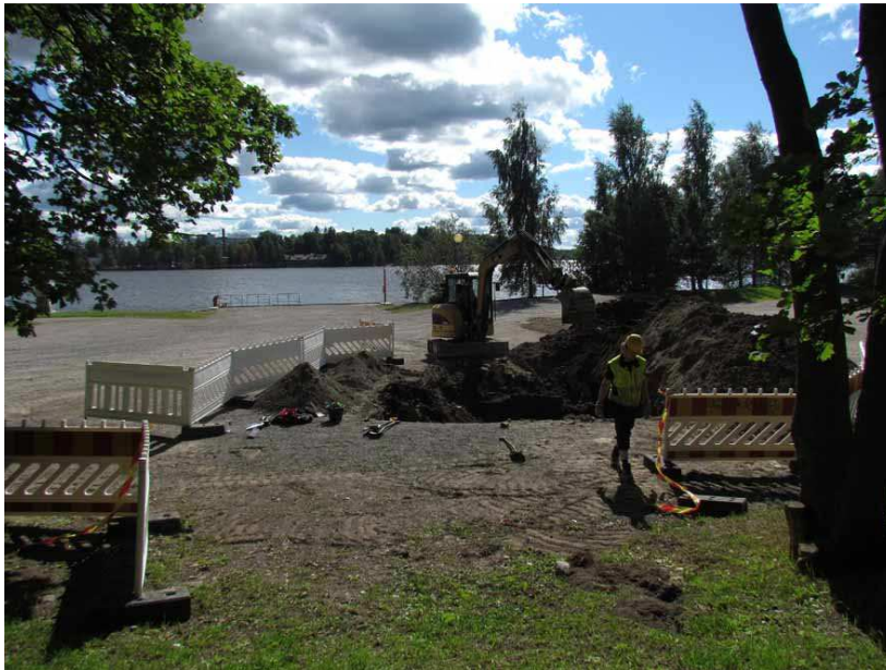
Kuva 35. Koeoja 4 Eteläpuiston hiekkakentän pohjoisreunassa. Kuvattu pohjoisesta. (Kuva: Tampere, Frenckellin kalkkiruukin ja Nalkalan tiiliruukin koekaivaus 2015: 20)
