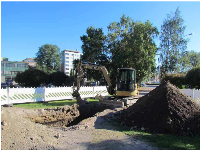
Kuva 50. Koeija 3 kuvattuna lounaasta. (Kuva: Tampere, Frenckellin kalkkiruukin ja Nalkalan tiiliruukin koekaivaus 2015: 35)
