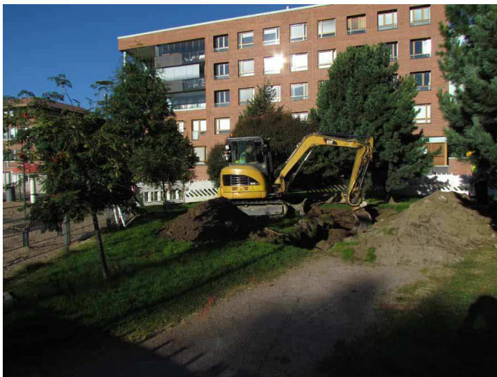
Kuva 47. Nalkalantorin koeja 2 kuvattuna koillisesta. (Kuva: Tampere, Frenckellin kalkkiruukin ja Nalkalan tiiliruukin koekaivaus 2015: 32)
