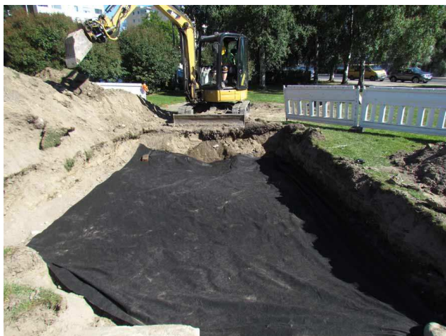
Kuva 61. Suodatinkankaalla peitetty koeaja 5 kuvattuna lounaasta. (Kuvat: Tampere, Frenckellin kalkkivuonin ja Nalkalan tiilivuonin koekaivaus 2015: 48)
