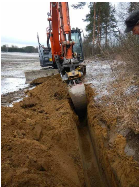
Kuva 5. Maakaapelikaivantoa kaivetaan. Kuvattu pohjoisesta. (Kuva: Pälkäne Kataja 2015:2)
