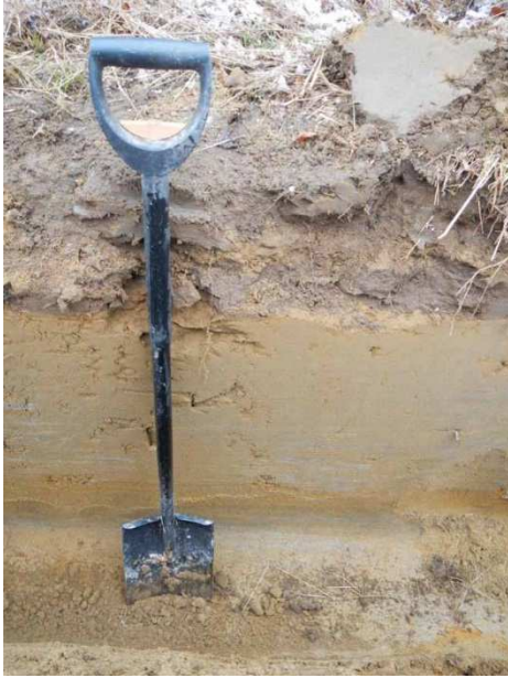
Kuva 6. Suurimmissa osassa kaapelikaivantoa peltomullan alla oli alueen luontainen maannos, vaalea hiesu. (Kuva: Pälkäne Kataja 2015: 3)
