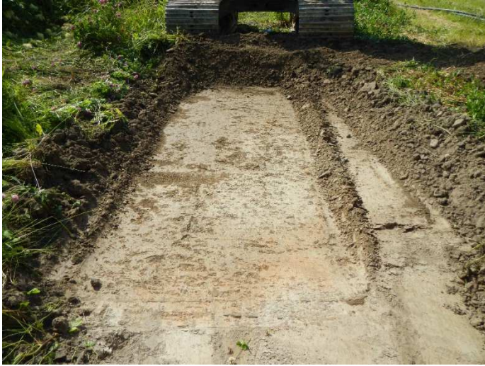
Kuva 9. Punertavaksi värjäytyneitä silttiä/savea Pitkäjärventien länsipuolisen kaivannon eteläpäässä. Kuvattu pohjoisluoteesta. (Kuva: Orivesi pitkäjärvi 2015: 7)
