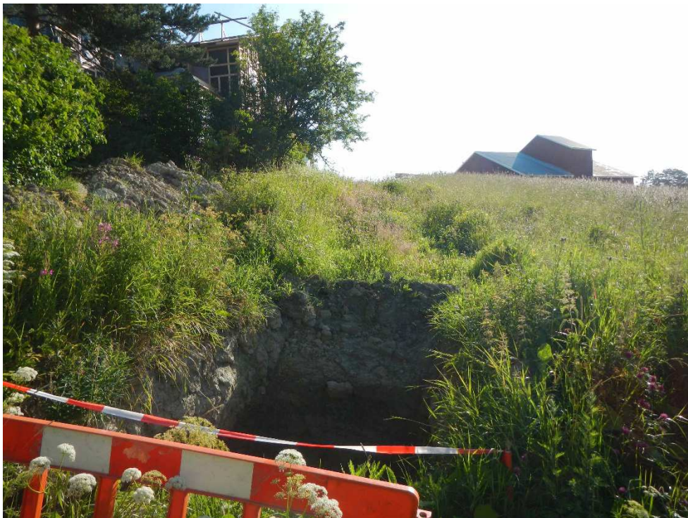
Kuva 2. Pitkäjärventien itäpuoleinen alituskaivanto kuvattuna länsilounaasta. (Kuva: Orivesi pitkäjärvi 2015: 1)
