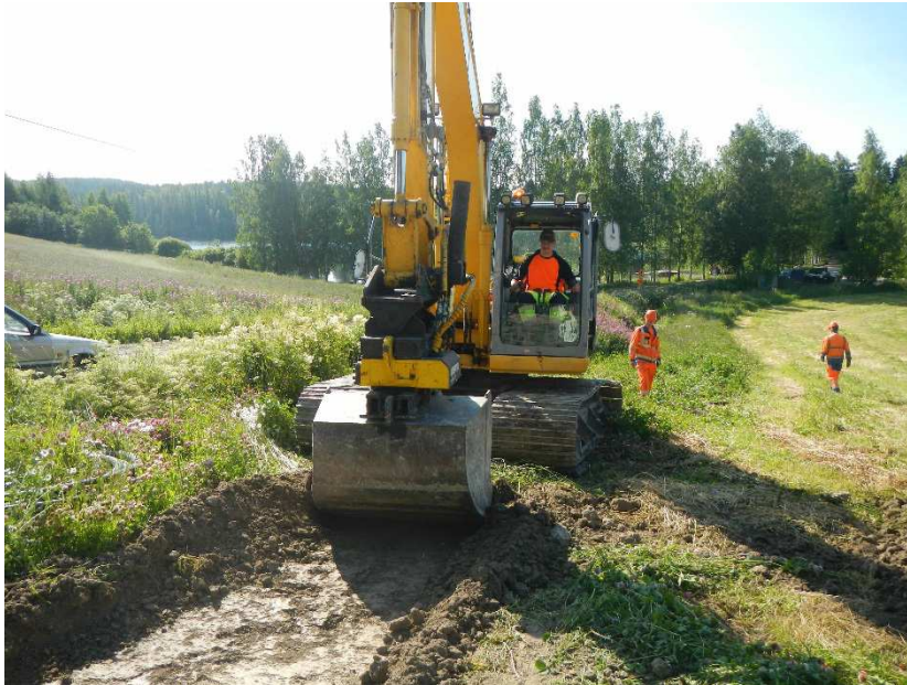
Kuva 5. Vesihuoltolinjausta kaivetaan. Kuvattu pohjoisesta. (Kuva: Orivesi pitkäjärvi 2015: 3)
