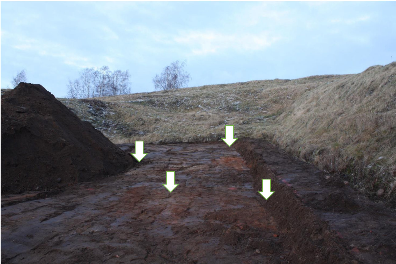
Kuva 2. Vallien välinen alue tasoittamisen jälkeen. Valkoiset nuolet osoittavat paikkoja, joissa maakerrosten rajapinnassa oli havaittavissa tiilimurskaa ja kalkkilaastia (vasemmanpuoleisin nuoli). Suunta S-N. Kuva: P. Kouki.
