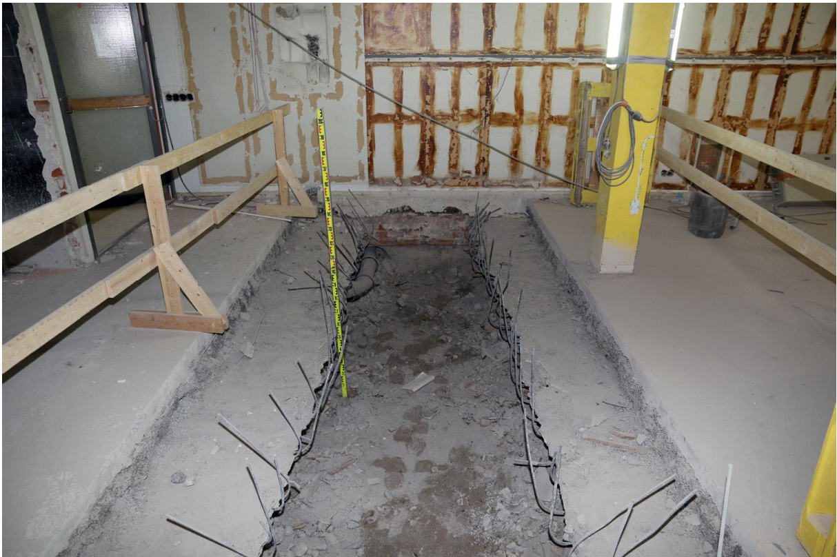
Kuva 22. Tilan eteläosan lattiaan on tehty kaivanto. Näkyvissä erilaisia harjateräksellä vahvistettuja valutasoja. Pohjalla näyttää olevan hiekkaa. Kuvaussuunta W. Kuvaaja Markku Heikkinen 16.6.2015.
