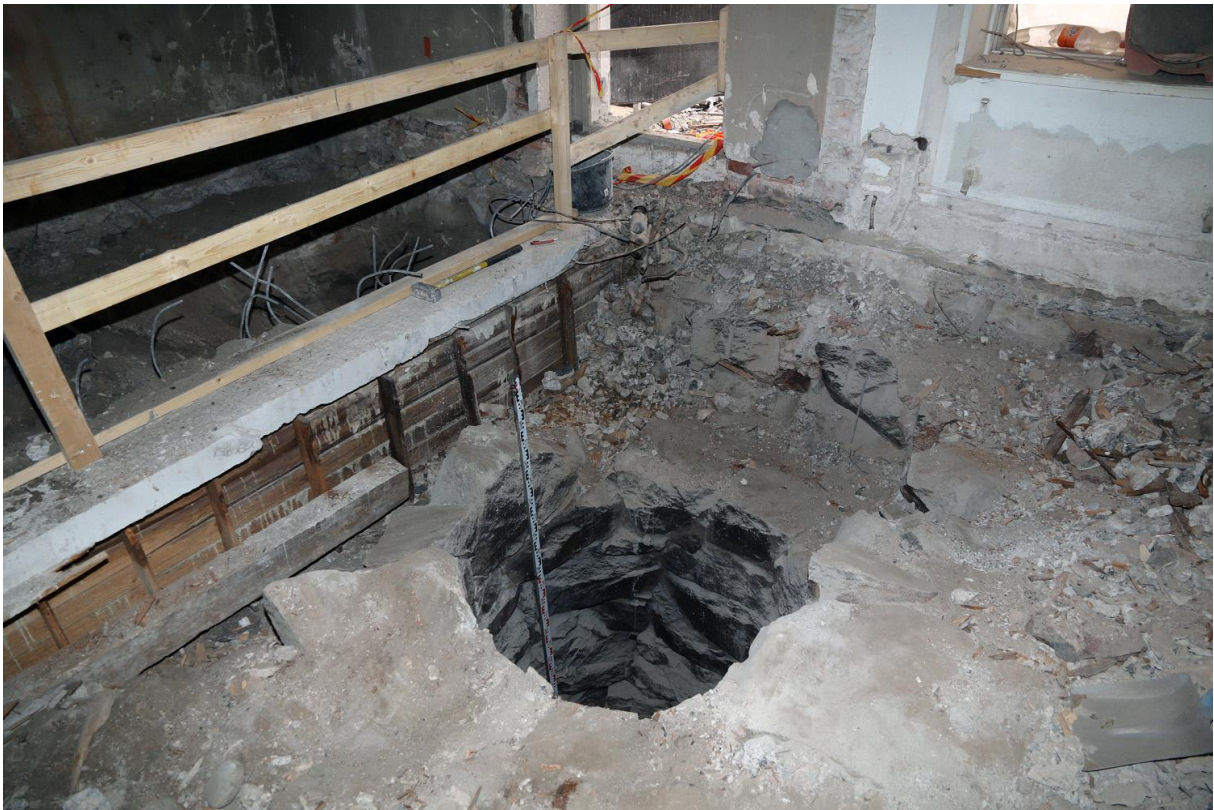
Kuva 4. Kaivon ympäristö on raivattu irtomaasta, betoninpaloista ja puusälästä. Taustalla näkyy ovi sisäpihalle. Oven ja ikkunan välissä näkyy jäännös 1962 tehdystä väliseinästä. Puinen pystyseinä kaivon pohjoispuolella on betonivalun tukirakenne. Kuvaussuunta NE. Kuvaaja Markku Heikkinen 16.6.2015.
