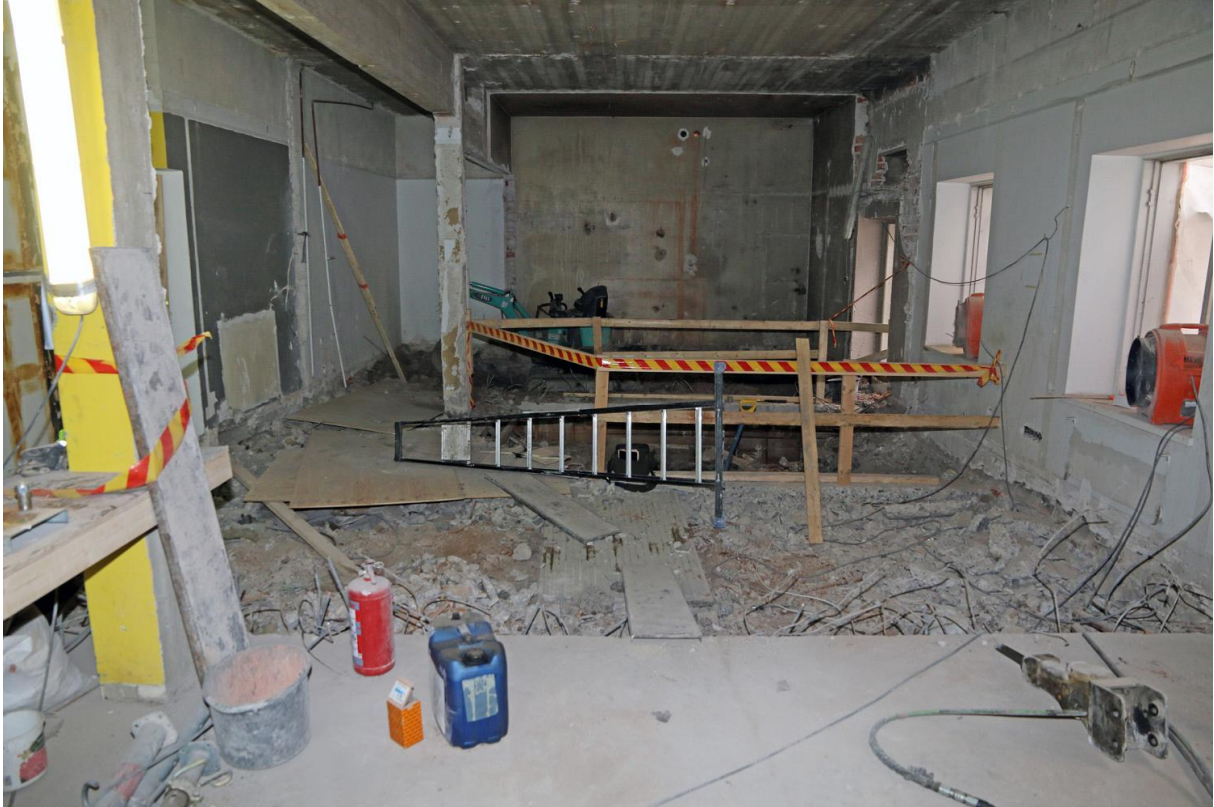
Kuva 3. Yleiskuva tilasta F104. Kaivon löytökohta on reunustettu lautakaitein. Osa tilan betonilattiasta on jo purettu ja väliseiniä myös. Kuvan etualalla lattian korkeus on 4,57 m. Kuvaussuunta N. Kuvaaja Markku Heikkinen 16.6.2015.
