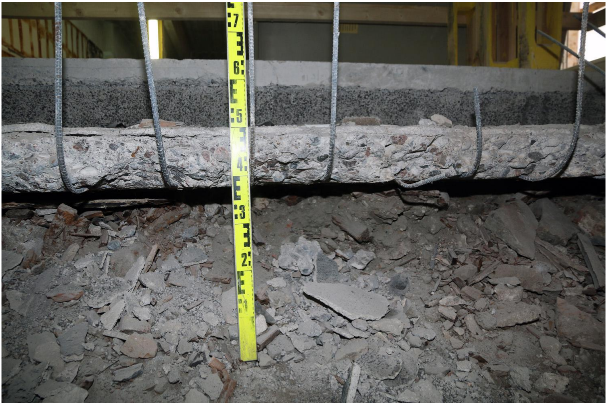
Kuva 24. Tilan eteläosan lattiaan tehdyn kaivannon pohjoisprofiili. Betonitasojen alla on tiiltä ym. purkumassaa. Kuvaussuunta N. Kuvaaja Markku Heikkinen 16.6.2015.
