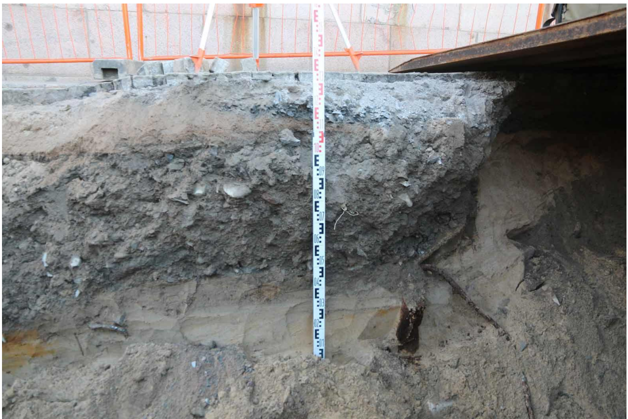
Kuva 33. Havaintopiste 12 sijaitsi kaivannon länsiprofilissa. Alin vaalea kerros vaikuttaa puhtaalta, mutta sen päällä oleva harmaampi hieno hiekka on täyttöhiekkaa. Sama harmaa hiekka nousee korkealle ajosillan alla. Profiilissa näkyy laho puupaalu ja mittaskaalan vasemmalla puolella kaapeli. Yläosa on täyttösoraa. Kuvaussuunta länteen. Markku Heikkinen/HKM 20.10.2015.
