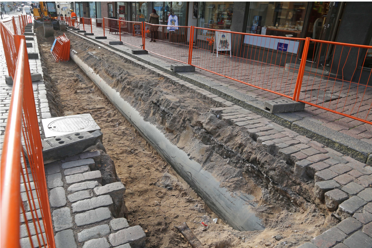
Kuva 2. Kaukojäähdytyskaivantoa Unioninkadulla Aleksanterinkadun ja Pohjoisesplanadin välillä. Kaivannon länsilaidassa sijaitsivat vuonna 2002 asennetut kaukolämpöputket. Aivan kuvan alalaidassa näkyy vanha kaasuputki, joka sijaitsi noin metrin syvyydellä. HP1 sijaitsi lähellä kuvassa näkyvää metallikantista kaivoa. Kuvaussuunta etelään. Heini Hämäläinen/HKM 13.10.2015.
