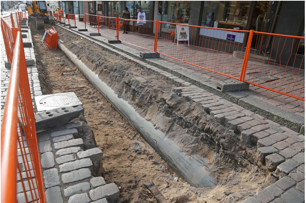
Kuva 12. Kaukojäähdytyskaivantoa Unioninkadulla Aleksanterinkadun ja Pohjoisesplanadin välillä. kaivannon länsilaidassa sijaitsivat vuonna 2002 asennetut kaukolämpöputket. Aivan kuvan alalaidassa näkyy vanha kaasuputki, joka sijaitsi noin metrin syvyydellä. HP1 sijaitsi lähellä kuvassa näkyvää metallikantista kaivoa. Kuvaussuunta etelään. Heini Hämäläinen/HKM 13.10.2015.
