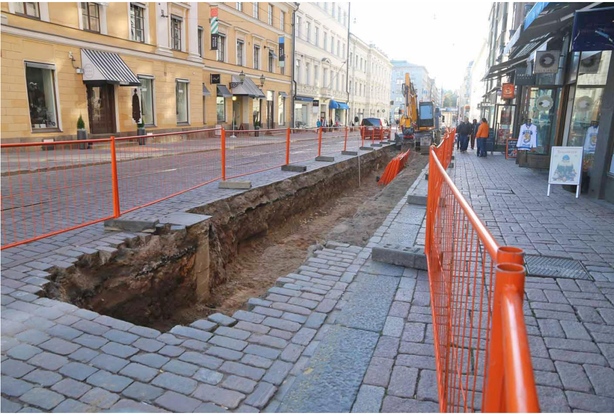
Kuva 1. Kaukojäähdytyskaivantoa Unioninkadulla Aleksanterin-kadun ja Pohjoisesplanadin välillä. Kuvaussuunta etelä-kaakkoon. Heini Hämäläinen/HKM 13.10.2015.
