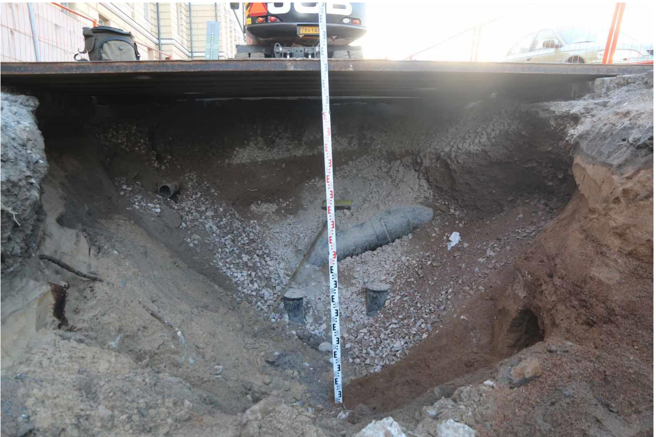
Kuva 28. Kaivannon pohjoispää pohjoiseen kuvattuna. Soran keskellä näkyy vuonna 2010 asennetut kaukojäädtytysputket. Oikealla havaintopiste 10. Ajorampin alla näkyy myös vanha kaasuputki. Kuvaussuunta pohjoiseen. Markku Heikkinen/HKM 20.10.2015.
