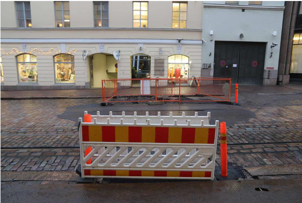
Kuva 13. Edellisissä kuvissa aloitettu itään suuntautuva kaivanto on avattu ja putket asennettu. Tältä alueelta ei päästy tekemään havaintoja. Kuvaussuunta länteen. Markku Heikkinen/HKM 10.12.2015.
