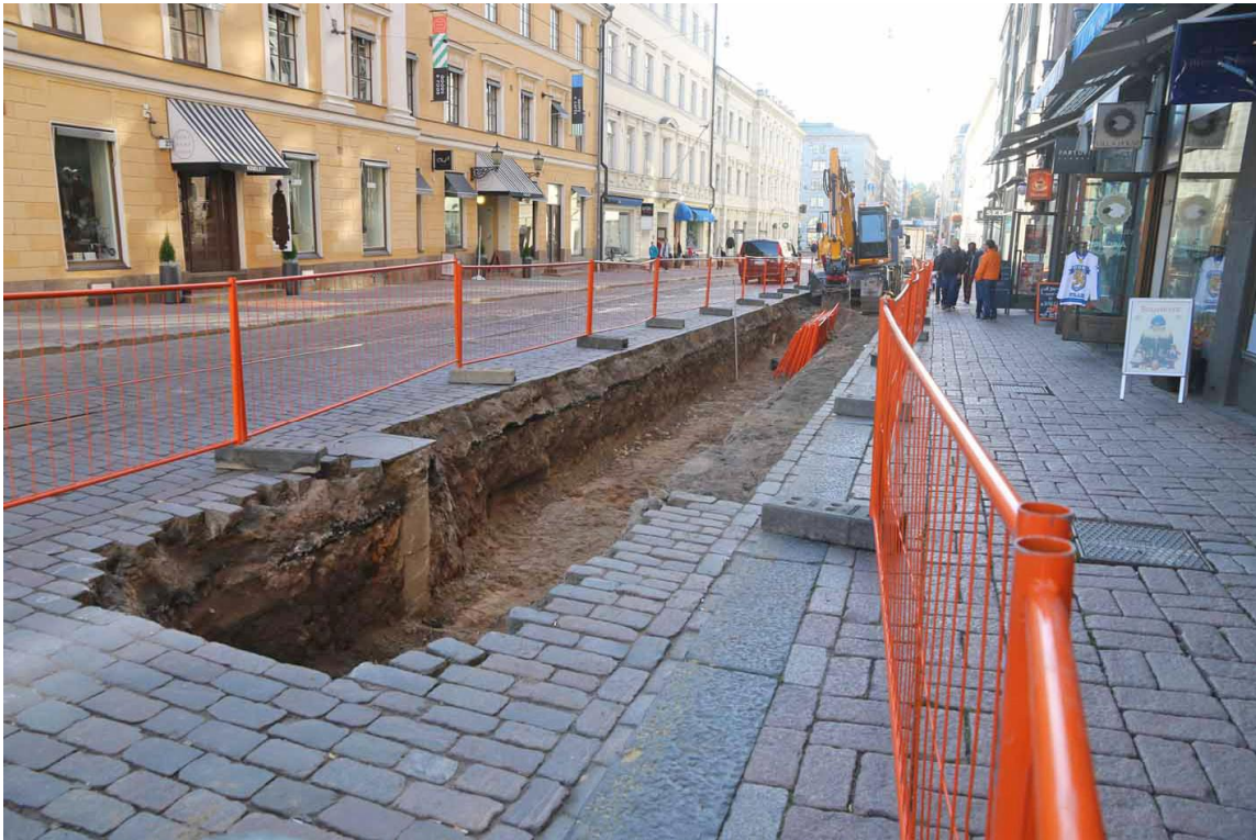
Kuva 10. Kaukojäähdytyskaivantoa Unioninkadulla Aleksanterinkadun ja Pohjoisesplanadin välillä. Kuvaussuunta etelä-kaakkoon. Heini Hämäläinen/HKM 13.10.2015.
