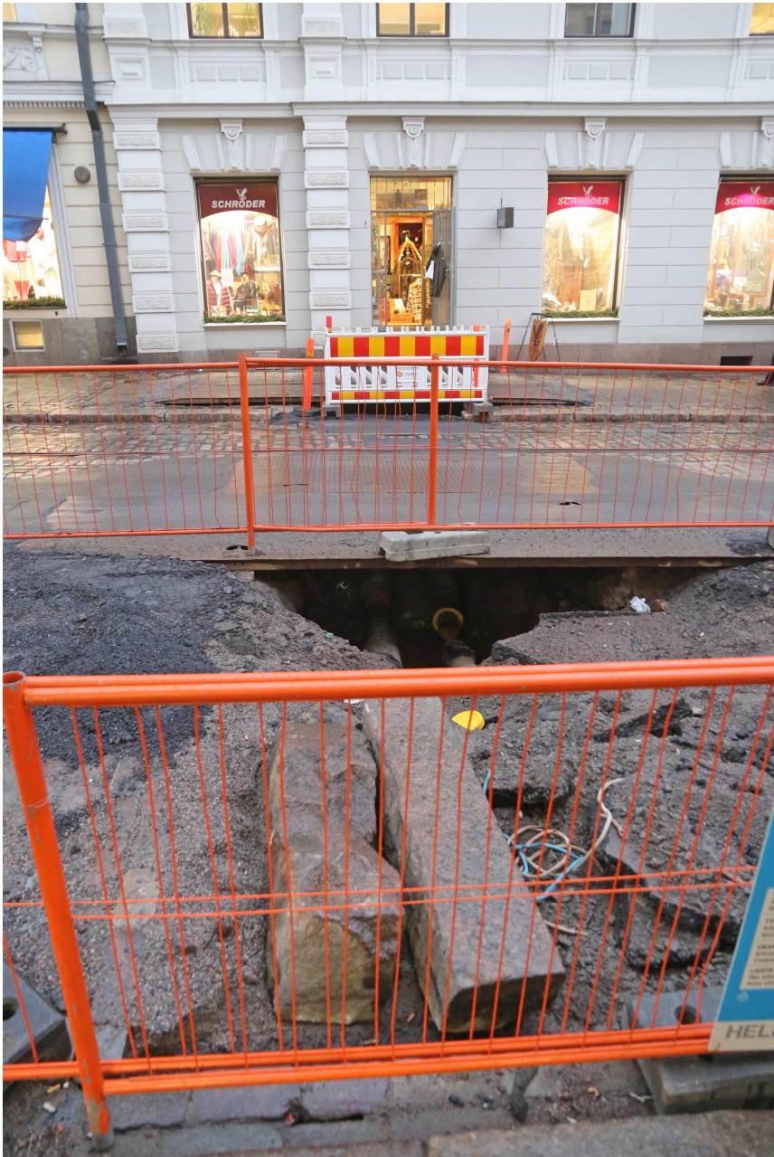
Kuva 23. Kaivannon eteläpääty, jonne on asennettu itä-länsi-suuntaisen putket. Putket pilkottavat ajorampin alla. Kuvaussuunta itään. Markku Heikkinen/HKM 10.12.2015.
