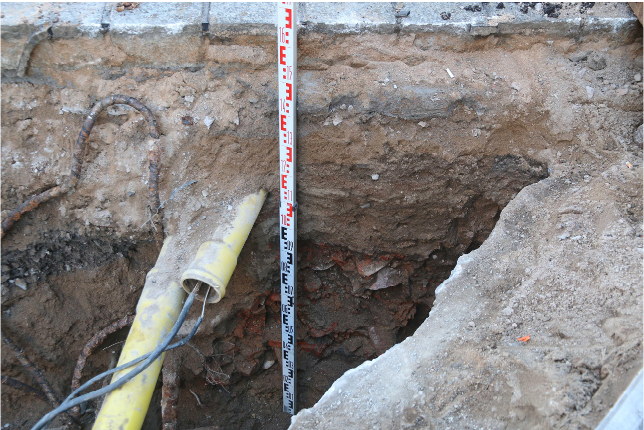
Kuva 21. Edellisen kuvan kaivanto itään päin kuvattuna. Havaintopiste 8. Kaivannon pohjalla on rakennusjätekerros, joka liittyy rakennuksen purkamiseen 1800-luvun alussa. Muut kerrokset päällä ovat uusia täyttömaita. Kuvaussuunta itään. Markku Heikkinen/HKM 16.10.2015.
