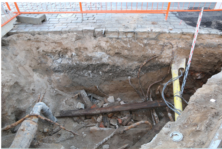
Kuva 28. Havaintopiste 8 mittaskaalan kohdalla. Kaivannossa on runsaasti kunnallistekniikkaa. Rakennusjätekerros saattaa liittyä rakennuksen purkamiseen 1800-luvun alussa. Muut kerrokset päällä ovat uusia täyttömaita. Kuopassa lojuu irtohirsi, joka mainittiin aiemmin. Kuvaussuunta itään. Markku Heikkinen/HKM 16.10.2015.
