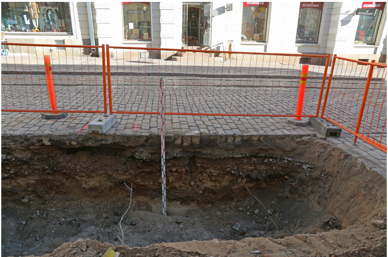
Kuva 19. Havaintopiste 6. Uudehkoja kaapeleita ja täyttömaita näkyvillä itäprofiilissa. Kuvaussuunta itään. Heini Hämäläinen/HKM 14.10.2015.
