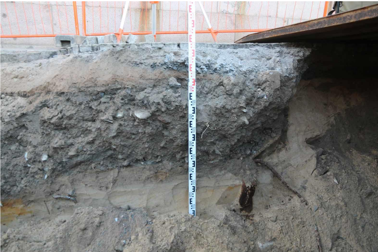
Kuvat 29 ja 30. Havaintopiste 12 sijaitsi kaivannon länsiprofiilissa. Alin vaalea kerros on puhtaasta hiekkaa, sen päällä oleva harmaa hieno hiekka tulkittiin täyttöhiekaksi. Sama harmaa hiekka nousee korkealle ajosillan alla. Profiilissa näkyy laho puupaalu ja mittaskaalan vasemmalla puolella kaapeli. Yläosa on täyttösoraa. Kuvaussuunta länteen. Markku Heikkinen/HKM 20.10.2015.
