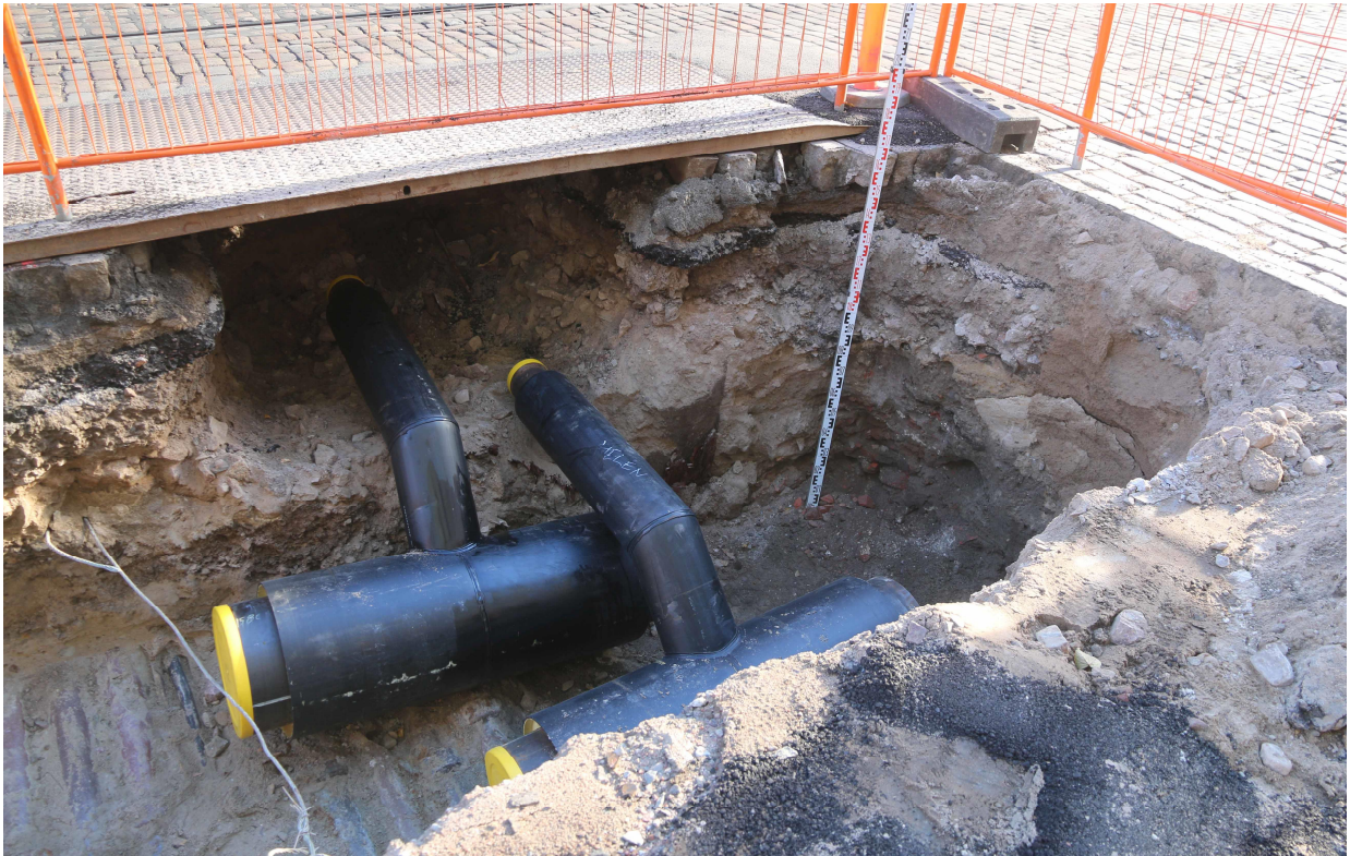
Kuva 22. Kaivannon eteläpääty, missä näkyy erilaisia täyttömaita. Kuvaussuunta kaakkoon. Heini Hämäläinen/HKM 2.11.2015.
