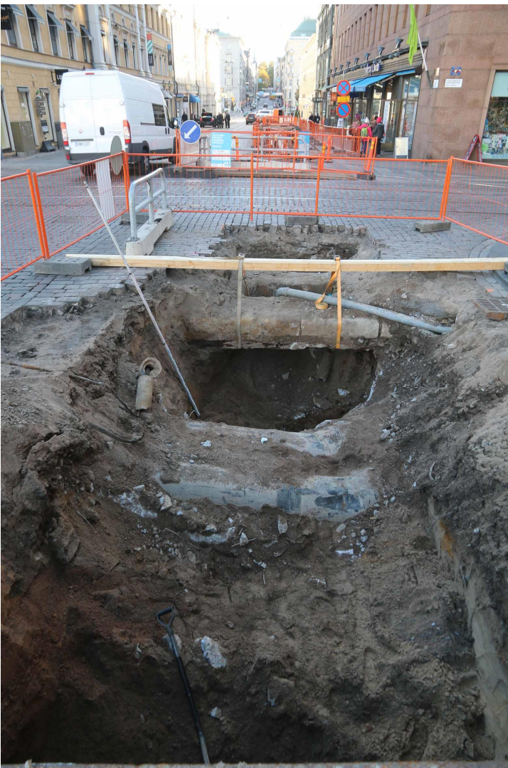
Kuva 24. Yleiskuva yliopiston vierustalta etelään. Kuvassa kaivanto risteysalueen pohjoispuolella. Kaivannossa on runsaasti eri-ikäisiä putkia ja johtoja. Kuvaussuunta etelään. Markku Heikkinen/HKM 20.10.2015
