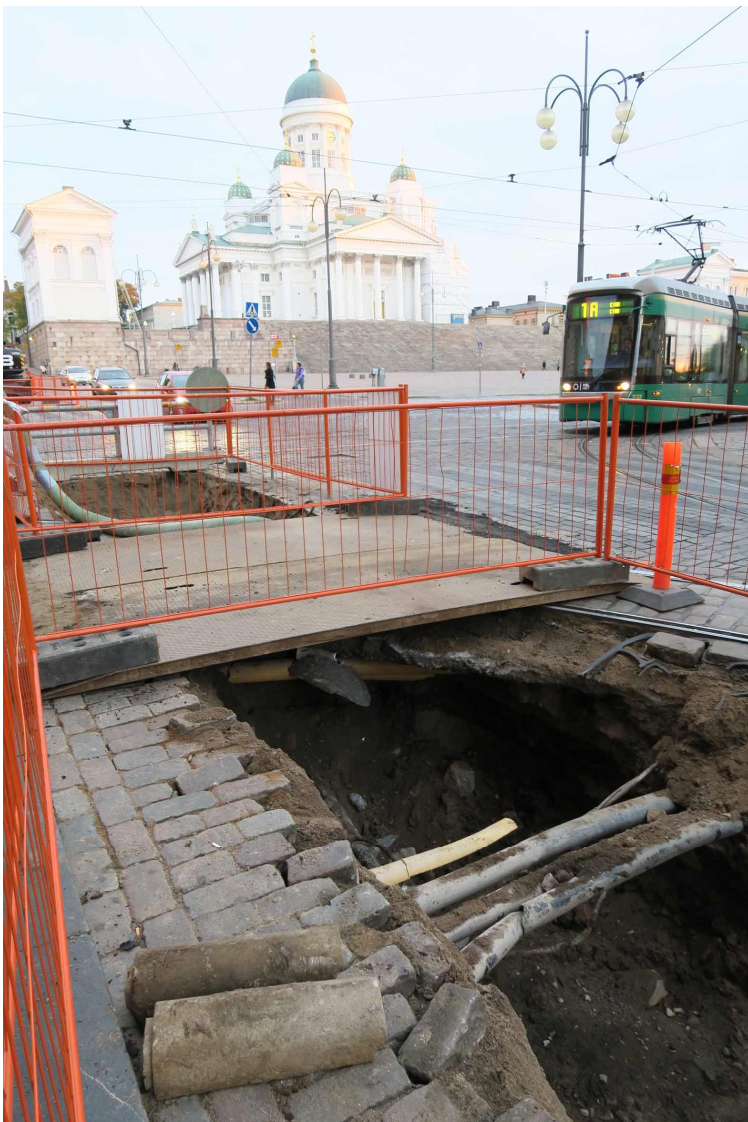
Kuva 24. Yleiskuva 16.10.2015 dokumentoidusta kaivannosta risteysalueella. Tiilirakenne sijaitsi ajosillan ja raitiotiekiskojen alla. Kuvaussuunta pohjoiseen. Markku Heikkinen/HKM 16.10.2015.
