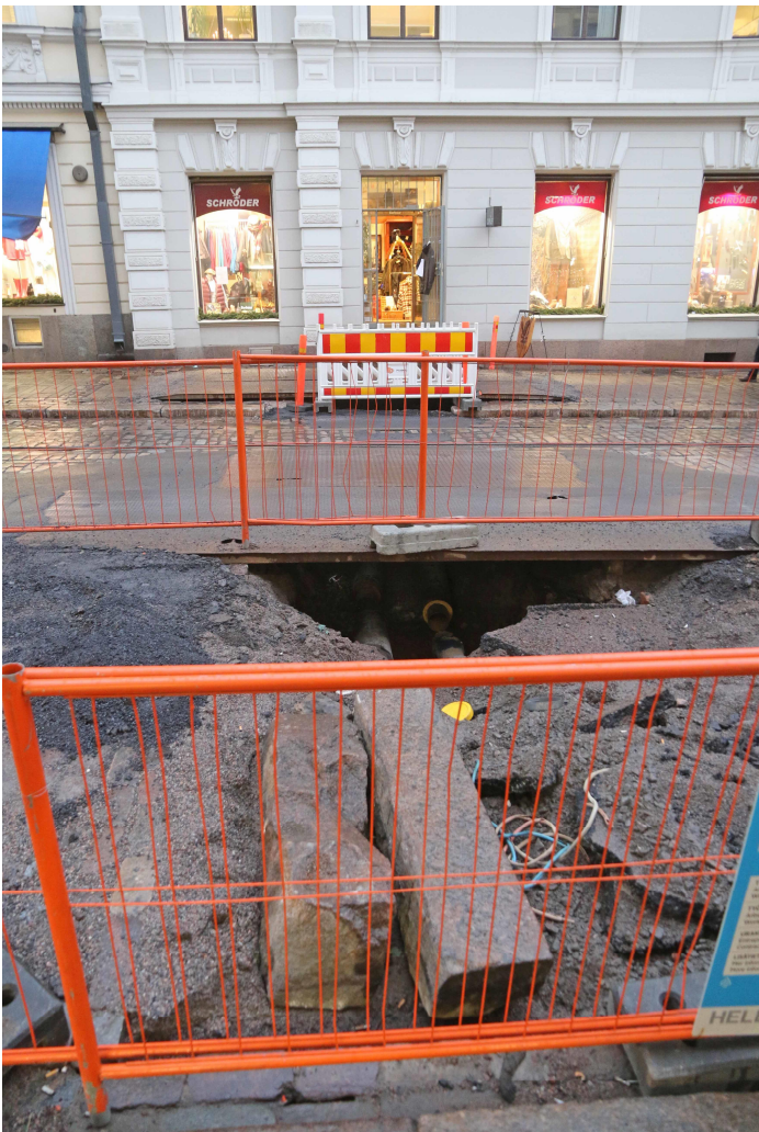
Kuva 14. Kaivannon eteläpääty, jonne on asennettu itä-länsi-suuntaisen putket. Putket pilkottavat ajorampin alla. Kuvaussuunta itään. Markku Heikkinen/HKM 10.12.2015.
