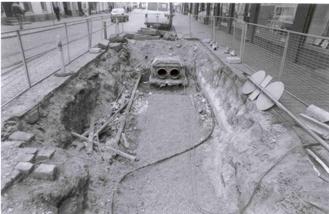
Kuva 11. Tässä kuvaparina kaukolämpöputkien vaihtamista vuodelta 2002 lähes samasta kohtaa kuin edellinen kuva. Vanhat rikkoutuneet putket poistettiin. Kuvassa saattaa näkyä sama kaasuputki, joka poistettiin vuonna 2015. Katua on tuolloin avattu lähes yhtä leveältä vyöhykkeeltä kuin 2015. Kuvaussuunta etelään. Kuva 274 342, Markku Heikkinen/HKM 17.5.2002.
