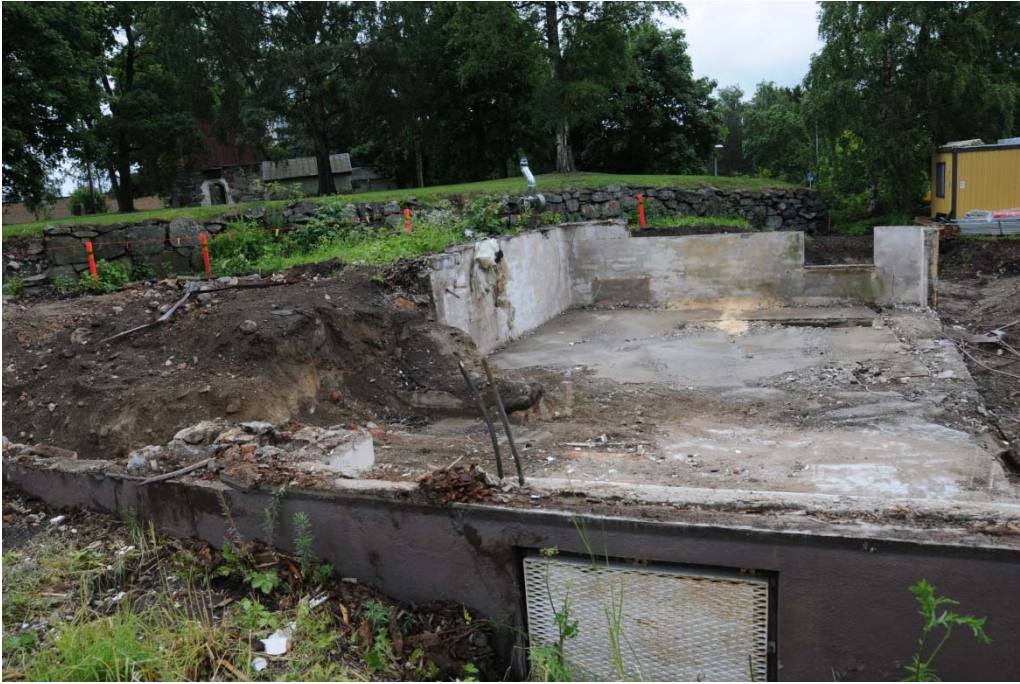
Jäljelle jätetty osa rakennusta, kaakosta.
