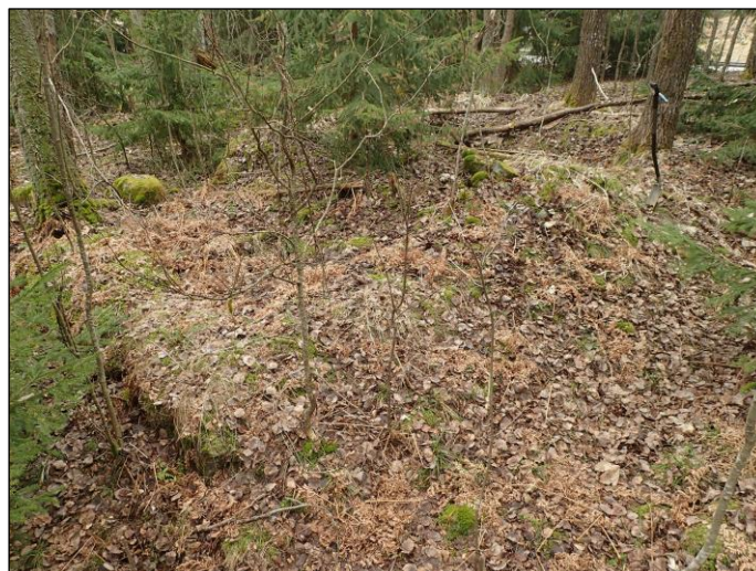
Rakennuksen perustan länsipää
