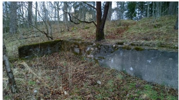
AKDG 4692:55. Betoninen rakenteen pohja, kaakosta. Kuvaaja: Petro Pesonen.
