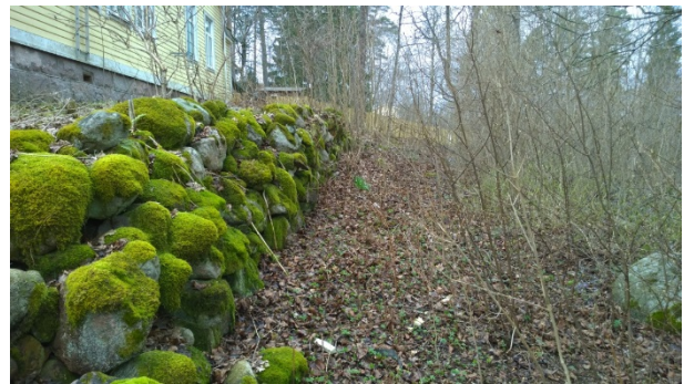
AKDG 4692:59. Tienpohjaa ja terassointi Sigurdsbergin alapuolella, idästä. Kuvaaja: Petro Pesonen.
