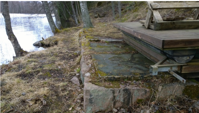
AKDG 4692:61. Vanhan rantasaunan betonilaatta, lännestä. Kuvaaja: Petro Pesonen.
