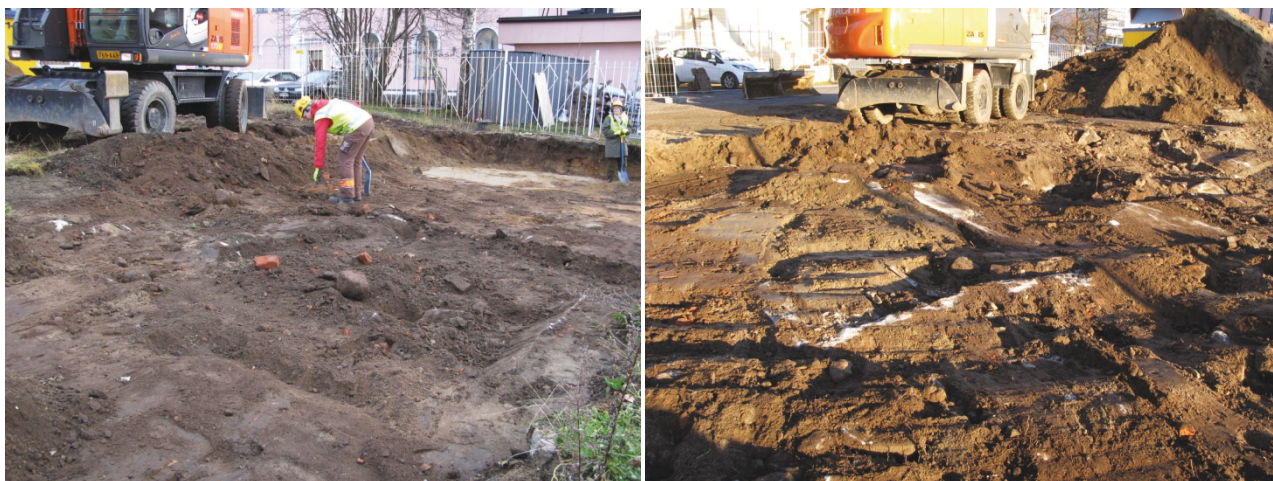
Vasemmalla SY2 purkukerroksen poistoa Välikadun varrella. Kuvan oikeassa reunassa erottuu paikoillaan ollut betonianturan R7 osa. Oikealla Eliksenkadun varren purettuun talon yhä paikoillaan ollut betonilattian osa kerroksessa SY2. AKDG4495:10 ja 42
