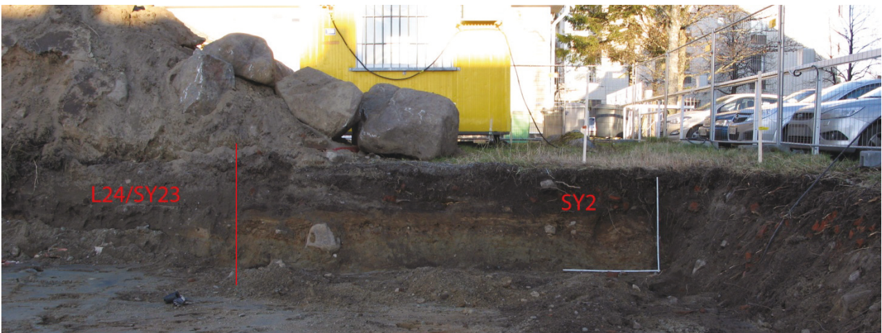
Koillisprofiilin itäpää, kuvaan on hahmoteltu punaisella purkujätekerros SY2 ja profiiliin jatkunut vesi- ja viemärikaivanto L23 AKDG4495:38
