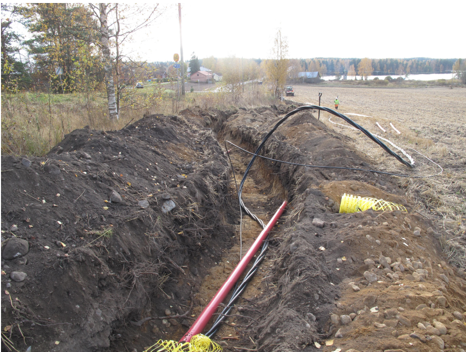
Kaapelikaivannon pohjoispää pellonreunassa. Kuva: Hannu Takala.
