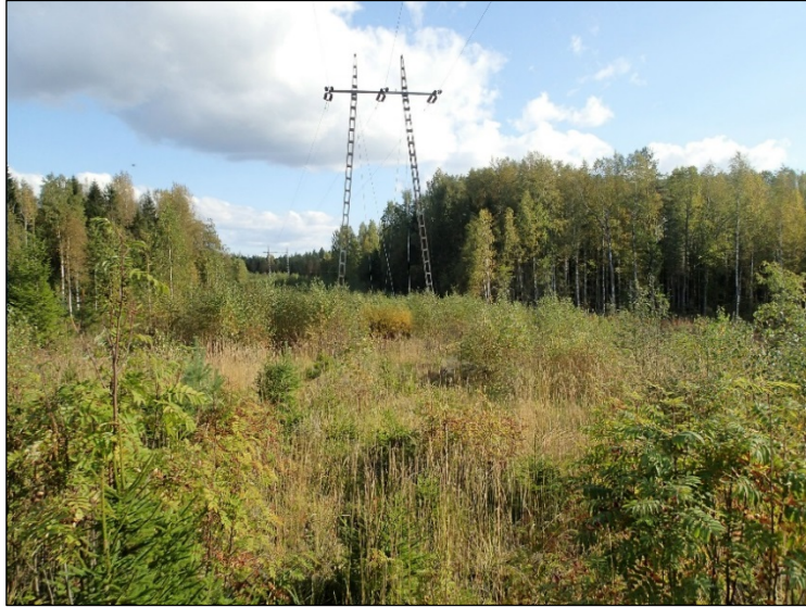
Pusikkoista ja vedenvaivaamaa maastoa linjakäytävällä Alakanavan luoteispuolella.
