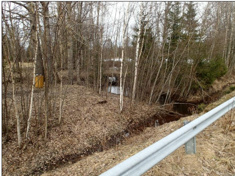
Vanha kivililta (myös myllyn paikka) näkyy puiden takana uoman ylittävän rakenteena. Kuvattu nykyiseltä maantieltä pohjoiseen.
