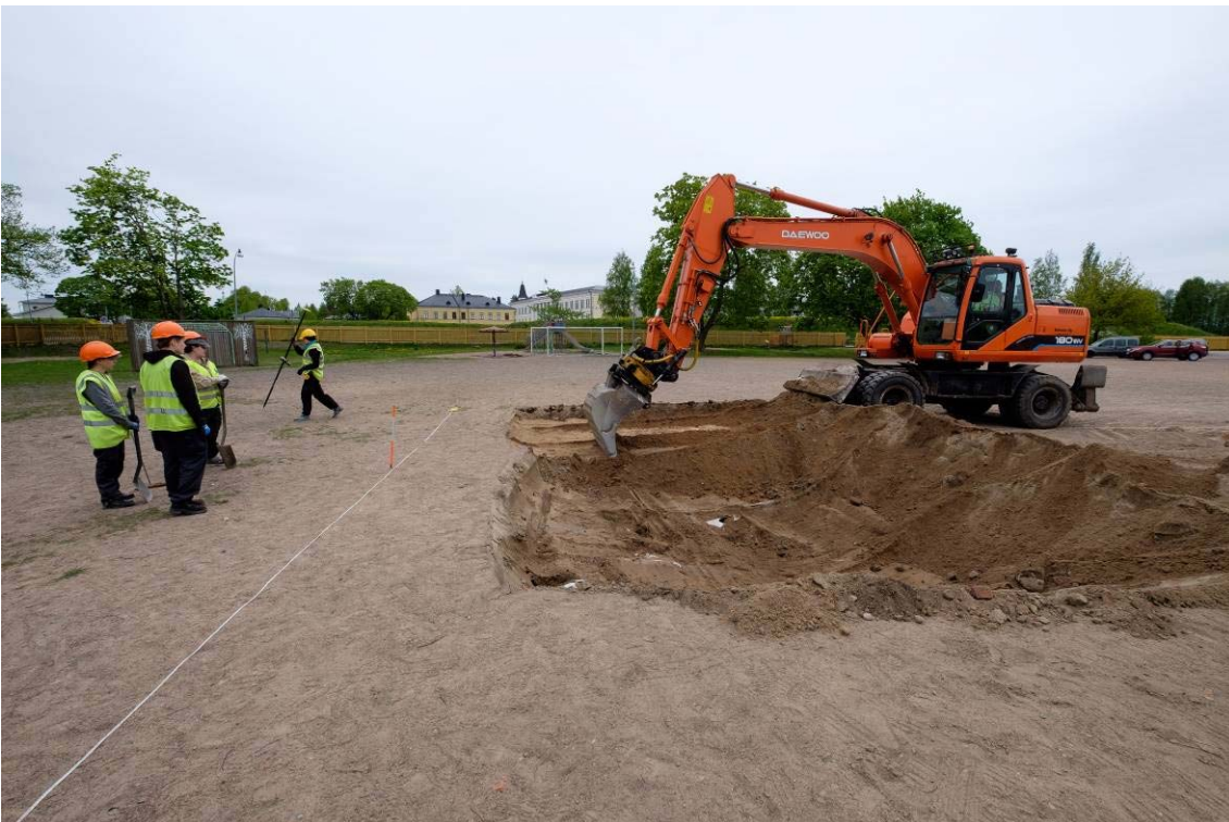
Kuva 2. Kaivinkoneella avataan aluetta, jolta löydettiin vuoden 2014 koekaivauksissa ihmisluiden keskittymä. Alue oli peitetty suodatinkankaalla. Kuva lännestä (AKDG4683:2)
