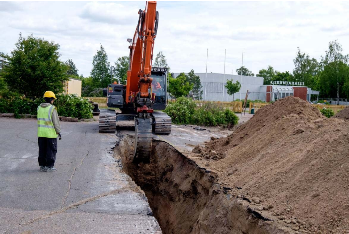
Kuva 31. Salla Pärssinen valvoo putkikaivannon kaivutyötä. Kuva lännestä. (AKDG4683:32)
