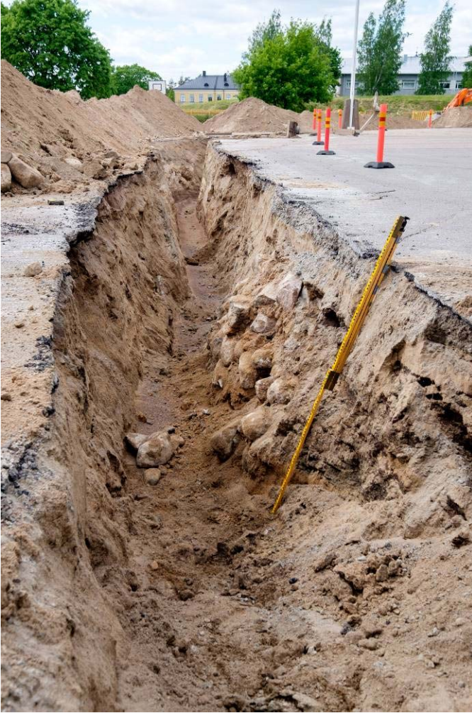
Kuva 36. Putkikaivanto ja siinä olleen lunetin muurin poikkileikkaus mittalatan kohdalla. Kuva idästä. (AKDG4683:37)
