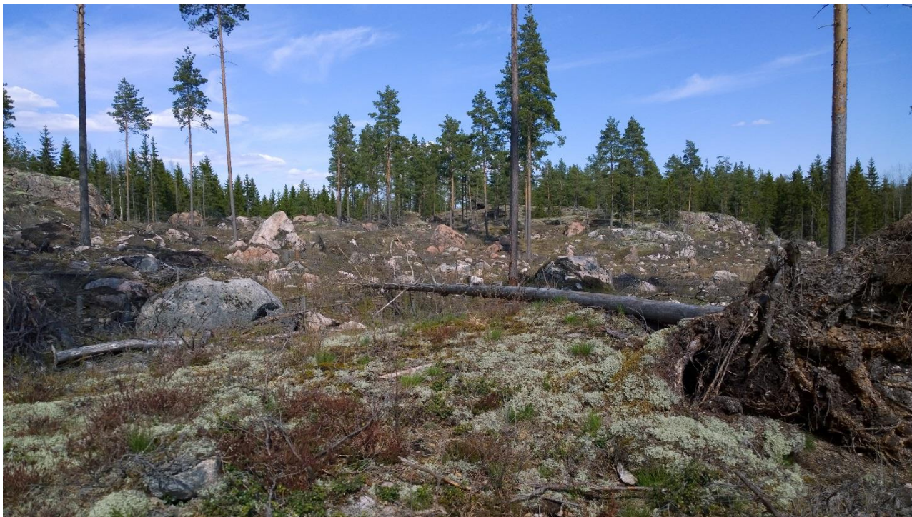
AKDG4699:13. Huoltoreitin rakennuspaikka voimalaitokselle 3. Kuvattu koilliseen.
