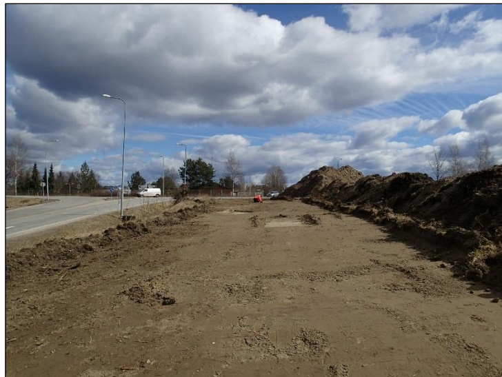
Valvonnassa kaivettua linjaa. Kuvattu itään. Teemu Tiainen tutkii linjalle tehtyä koekuoppaa.
