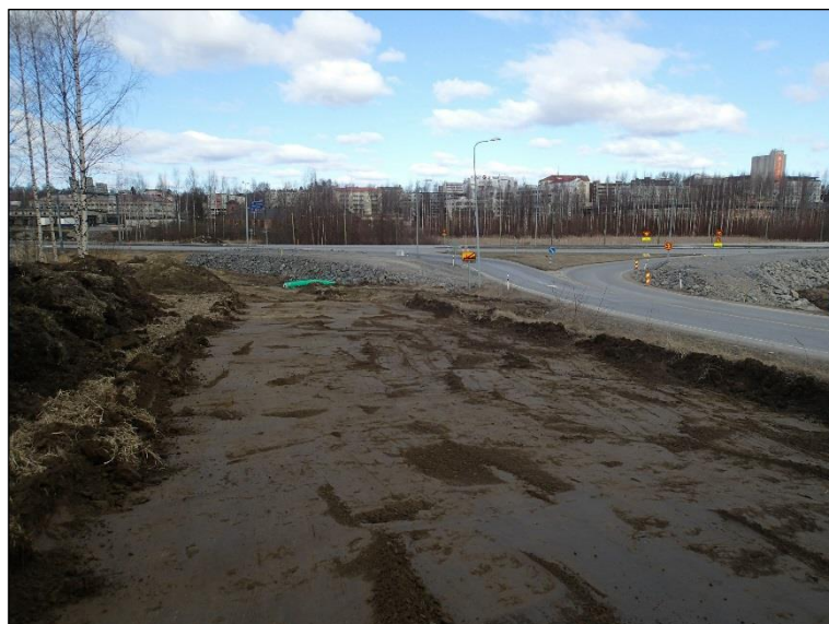
Valvonnassa kaivettavan linjan länsipää multakerroksen poistamisen jälkeen. Kuvattu länteen.
