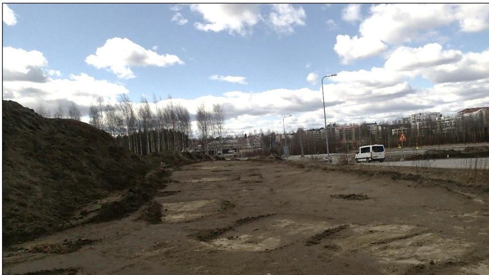
Valvonnassa kaivettua aluetta. Kuvattu koilliseen.
