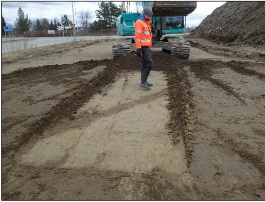
Kaivannon poikki menevä oja. Kuva Itään.
