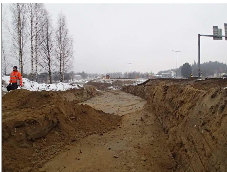
Risteyksen alue, syvään kaivettu osa. Kuvattu lounaaseen.
