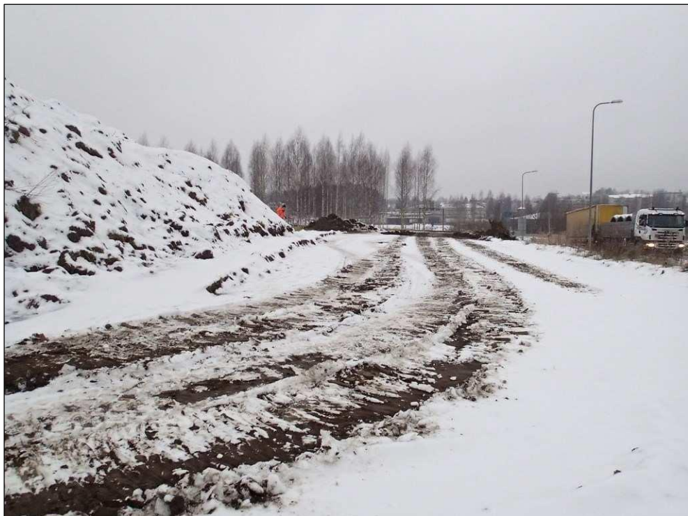
Peltoalue, kuorittu alue ja maakasa, taustalla risteysalue. Kuvattu luoteeseen.
