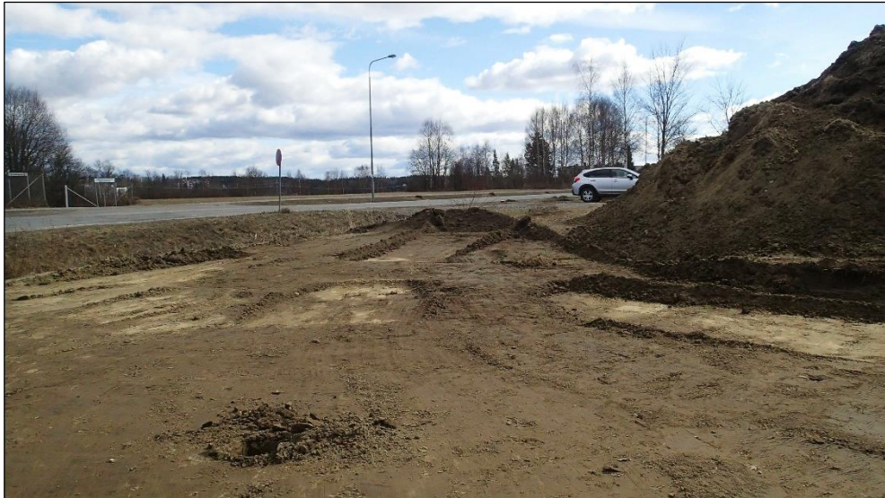
Valvonnassa kaivetun alueen itäsin pää. Kuvattu luoteeseen.
