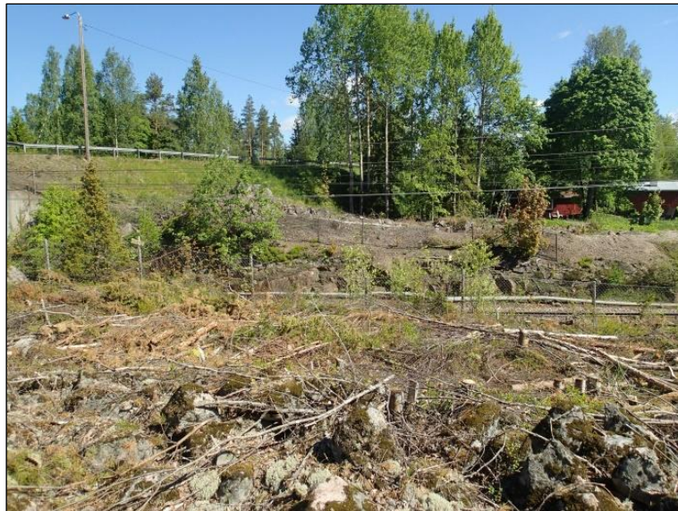
Vt 12 ylittää Viipurinradan litin länsiosassa. Valtatien uusi linjaus kulkee radan kohdalla hieman nykyistä etelämpänä. Koilliseen.
