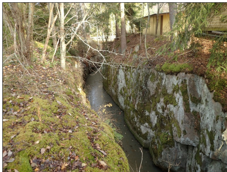
Kallioon räjäytettyä uoma vanhan myllynpaikan kohdalla. Pohjoiseen.
