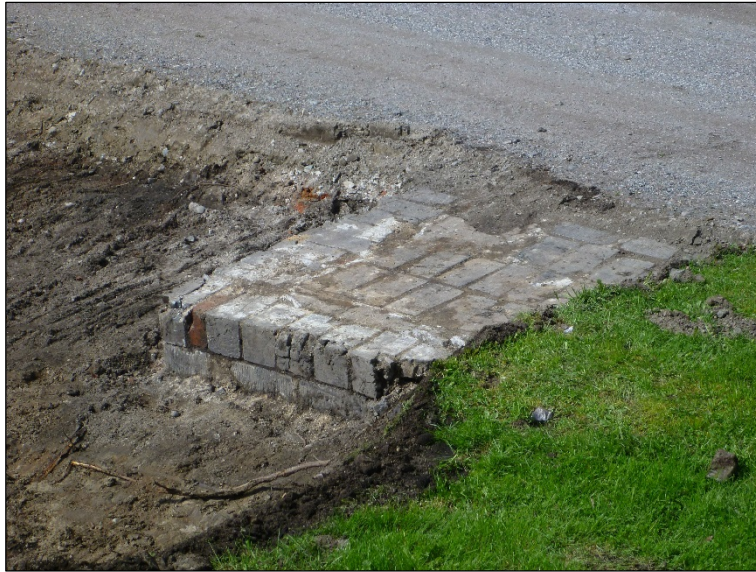
Rakenteen kaakkoisreunaa ja päällisiä. Kuvattuna lounaaseen.
