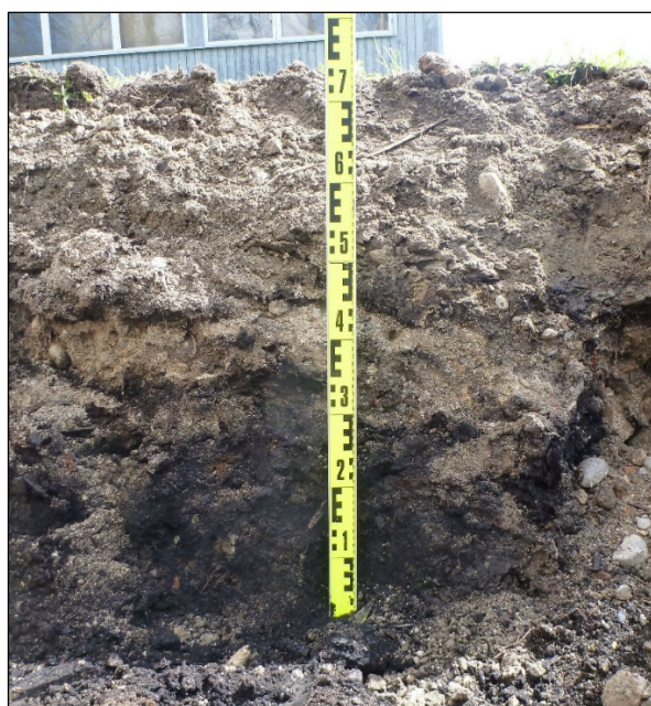
Viemärikaivannon linja perustuskaivannolta kohti etelään. Linja kaivettu koko matkalla olemassa olevan viemäriinjan kohdalle. Viemärikaivannossa sama eebenpuutyöstöjäännöksen tumma maa ja muutoin sekoittunut hiekka.
