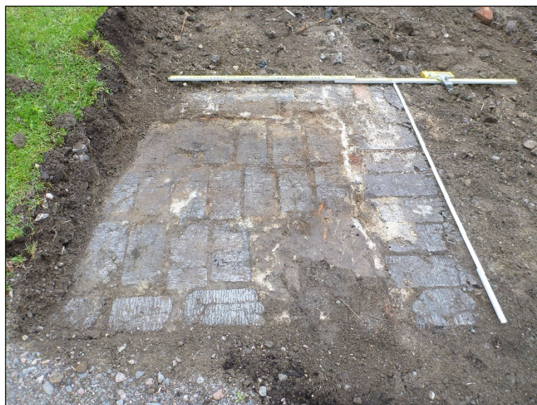
Rakenne kuvattuna itään.
