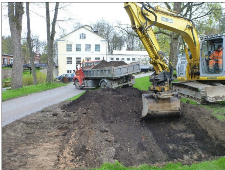
Kaivantoa kaivetaan. Kuvattu koilliseen.
