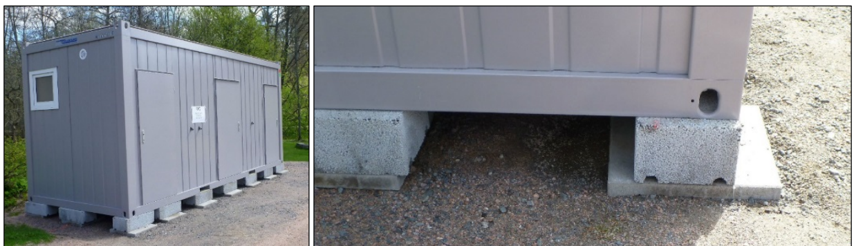
Vastaava konttikäymälä valmiina Fiskarsin leikkipuiston reunalla. Perustamistapa esitetty lähikuvana.
