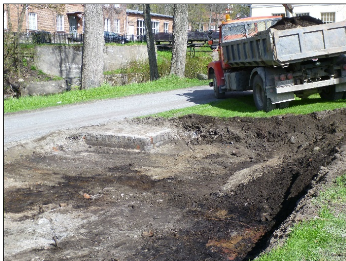
Kaivannon pohjoiskulma. Rakenne kaivannon kulmassa. Kuvattu pohjoiseen.
