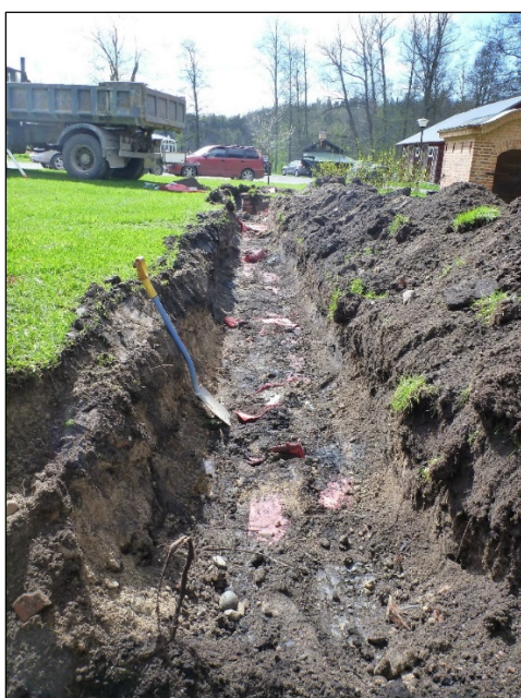
Viemärikaivannon linja perustuskaivannolta kohti etelään. Linja kaivettu koko matkalla olemassa olevan viemäriinjan kohdalle. Viemärikaivannossa sama eebenpuutyöstöjäännöksen tumma maa ja muutoin sekoittunut hiekka.
