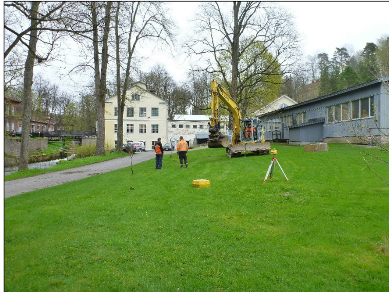
Paja-aukion nurmialuetta ennen koneellista kaivamista. Tulevan konttikäymälän sijoituspaikka kaivinkoneen vasemmalla puolella. Kuvattu pohjoiseen.
