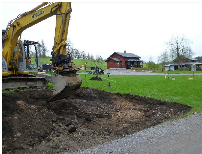
Kaivannon läntinen kulma. Ruskeaa täyttöhiekkaa. Kuvattu lounaaseen.
