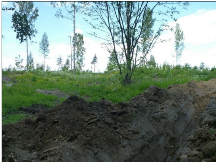
Määräsyvyyteen kaivettua kaivantoa. Taustalla röykkiöalue. Kuvattuna pohjoiseen.
