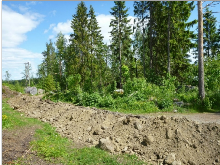
Tielinjalle kaivettua kaivantoa kuvattuna itään.
