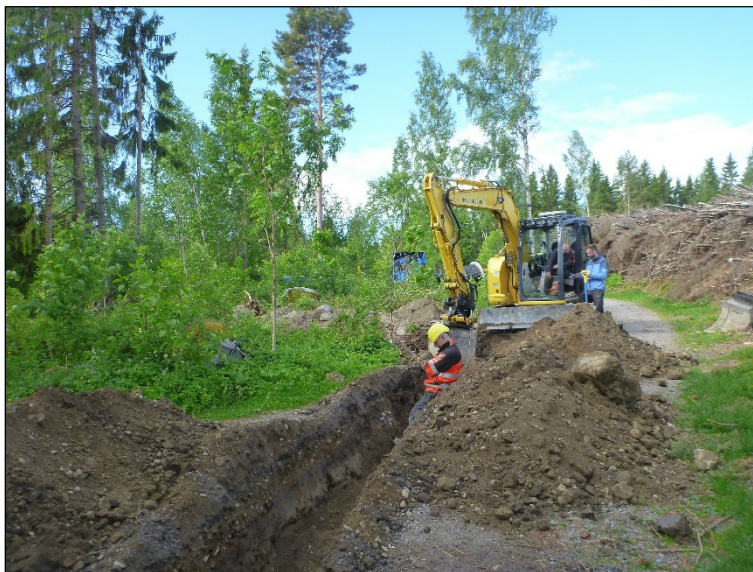
Tilanne alueella arkeologien saapuessa paikalle. Ilman arkeologista valvontaa kaivettua maakaapelilinjaa kaivinkoneen edustalla. Kuvattu etelään.
