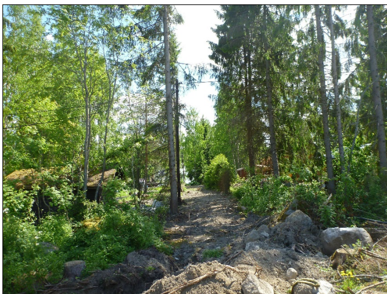
Luoteis- kaakko – suuntainen maakaapelikaivanto. Kaivettu ennen arkeologien saapumista paikalle. Kuvattu kaakkoon.
