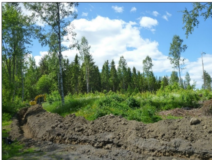
Valvonnassa kaivettu linjaa muinaisjäännösalueen kaakkoisosassa. Taustalla kumpareella röykkiöalue.
