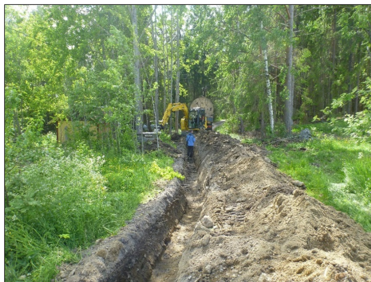
Valvonnassa kaivettu linjaa kuvattuna lounaaseen.
