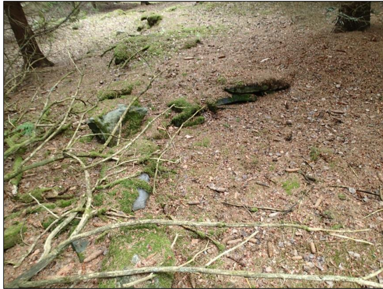
Jussilanhaka, alakohde A. Rakennuksen kivistä tehtyä perustusta. Etelään.
