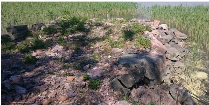
Kuva 15. Laituri on rakennettu kivilouheesta ja maa-aineksesta. Kuvaussuunta on koilliseen.
