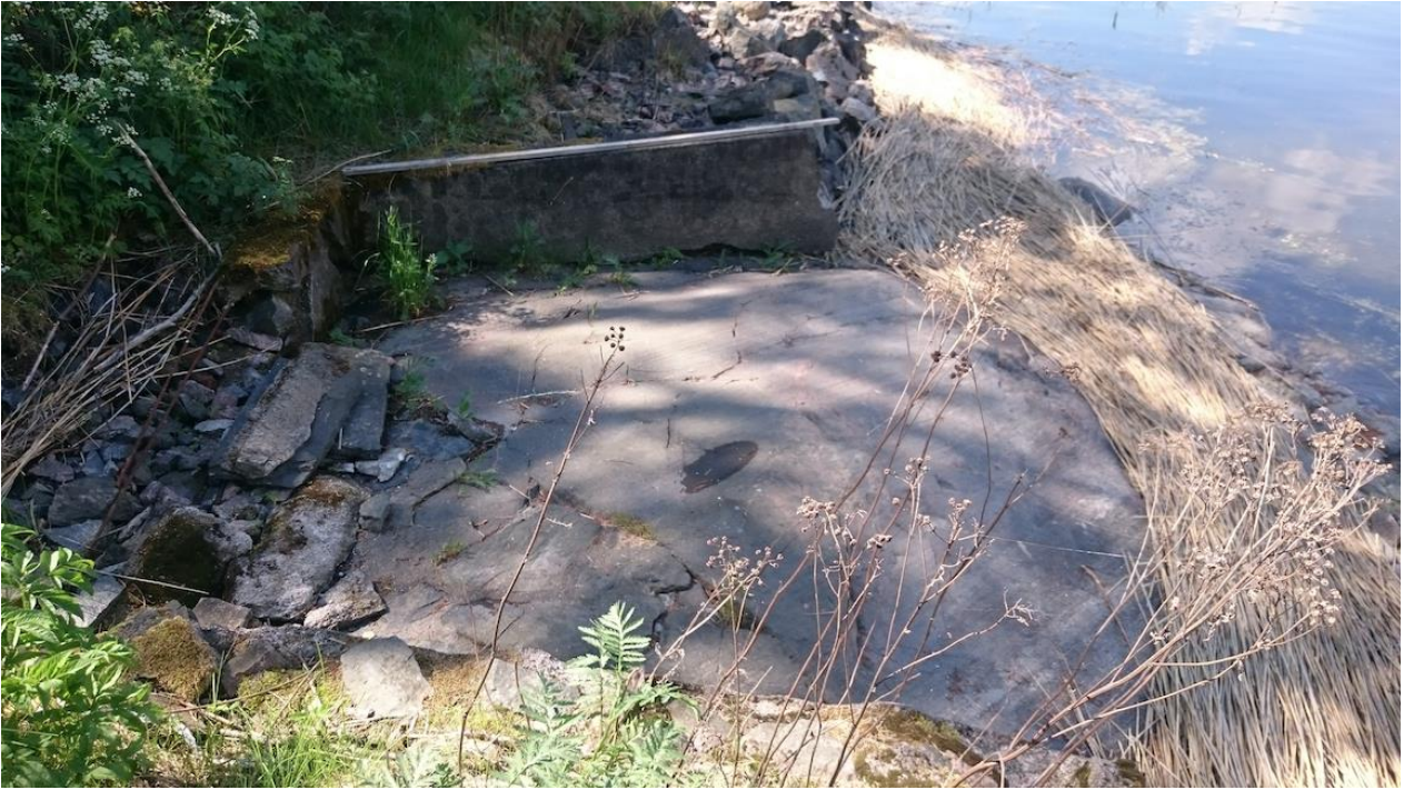
Kuva 10. Kuva saaren koillisosassa sijaitsevan rantamuurin yhteydessä olevasta betonista ja kivistä valmistetusta poukamasta. Aidattu alue on mahdollisesti toiminut uimapaikkana. Kuvaussuunta on länteen.
