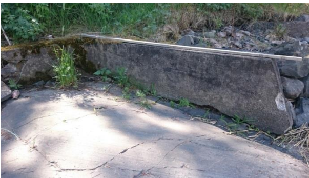
Kuva 11. Uimapaikan lounaisreunan betoniaitaa. Kuvaussuunta lounaaseen.
