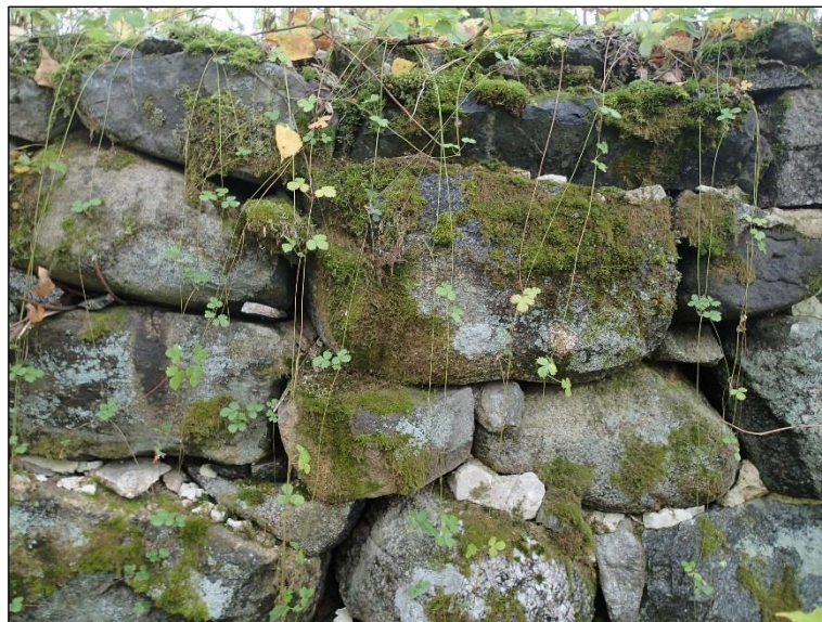
Rakennuksen jäännöksen kiviseinää myöhäiseltä historialliselta ajalta Kallioperän tilasta luoteeseen.
