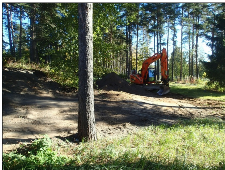
Alueen länsilaitaa maan tasauksen jälkeen. Itäkoilliseen.
