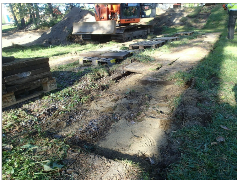
Keskeltä matonpesupaikkaa poistettujen laattojen kohtaa. Luoteeseen.
