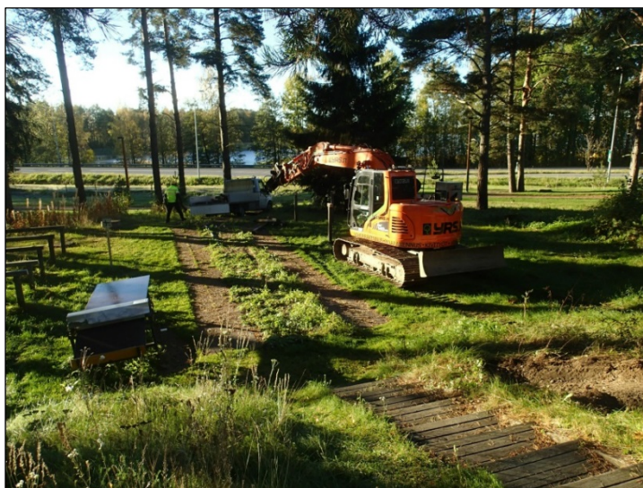
Kuivaustelineiden tolppien nyppäminen käynnissä. Etelään.
