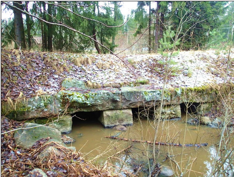
Kujala etl länsipuoli. Vanhan ratapohjan harkkokivinen silta. Itäkoilliseen.
