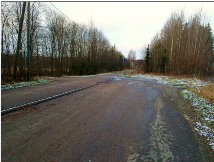
Vanha tielinja on käytössä pyörätienä, jonka vasemmalla puolella hahmottuu vanhan tien käytöstä pois jäänyt osuus. Luoteeseen.
