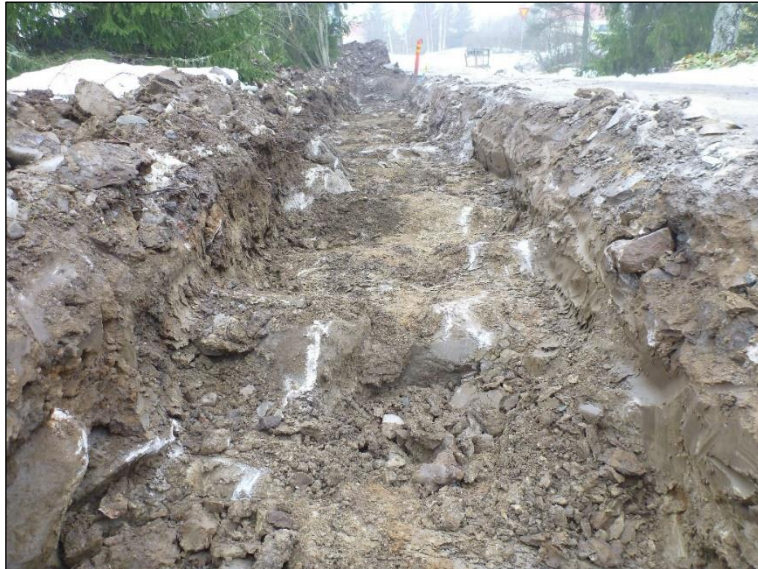
Valmiin kaivannon keski- ja lounaisosaa. Lounaaseen.
