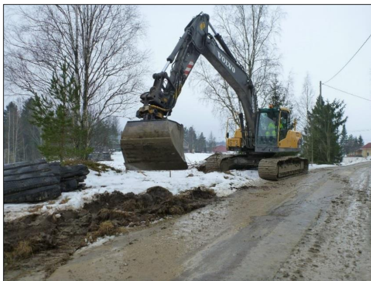
Tutkimusalueen koillisosa ennen kaivutöiden aloittamista. Lounaaseen.
