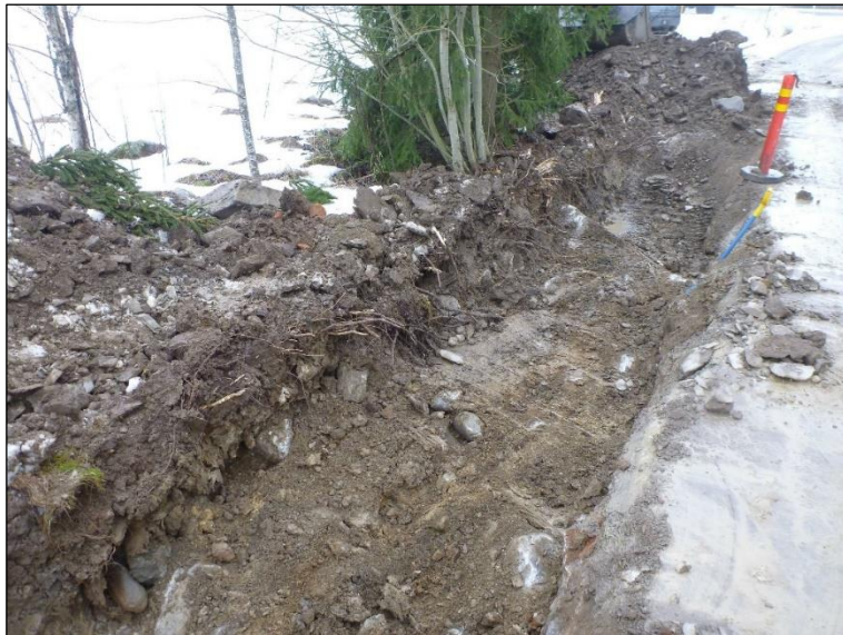
Valvotun kaivannon "ammuttua" lounaispäätä. Lounaseen.
