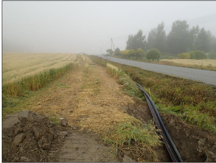
Valvonnassa kaivettavan alueen itäpääty ennen kaivutöiden aloittamista. Luoteeseen.
