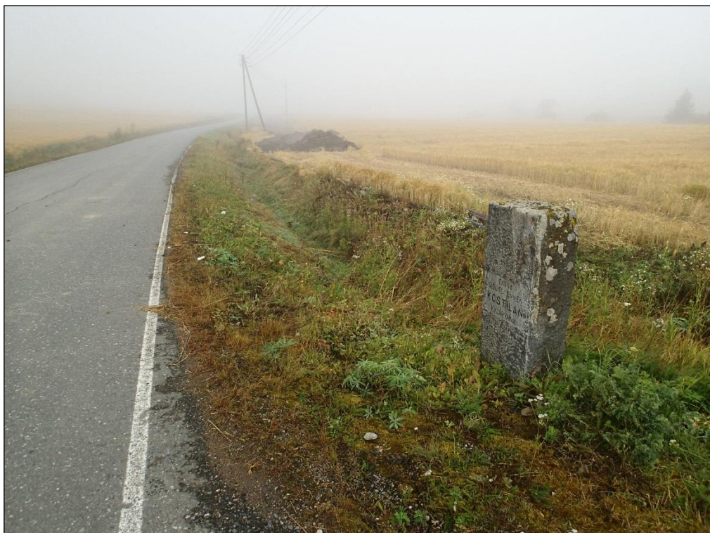
Valvonnassa kaivettavan alueen länsiosaa ennen kaivutöiden aloittamista. Luoteeseen.
