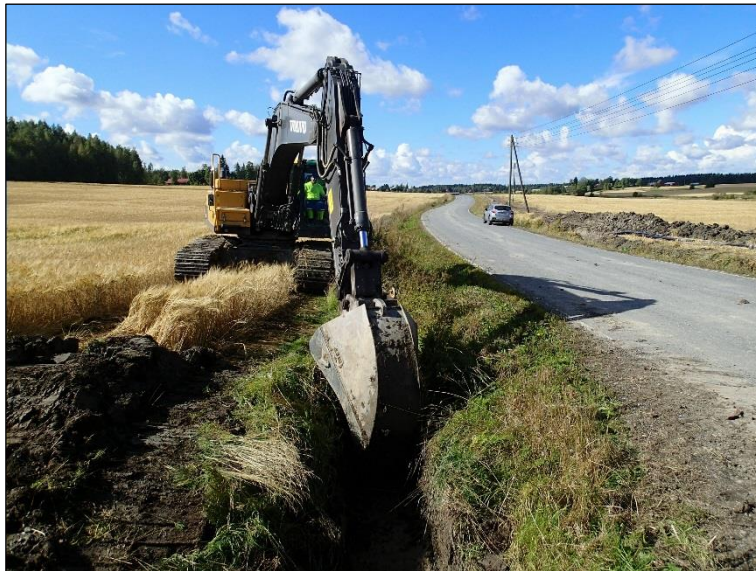
Konekaivua Vähä-Erkkiläntien länsipuolella, Kostilantien eteläpuolella. Luoteeseen.
