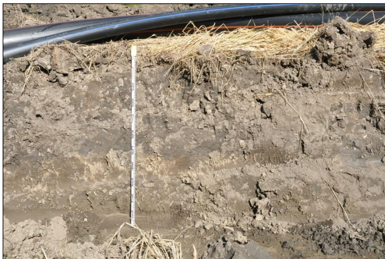
Tumman maan kerrosta paikallistien pohjoispuolisen kaivannon länsipäässä. Etelästä.
