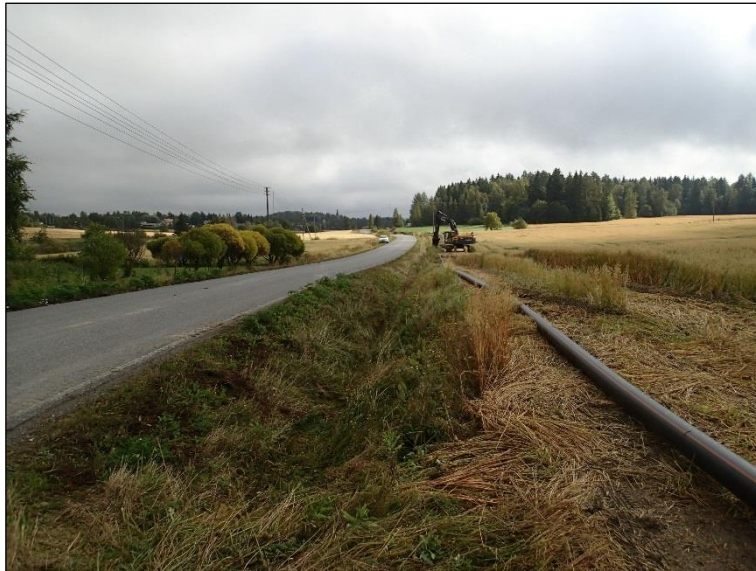
Kaivinkone valvonnassa kaivettavan linjan itäisimmässä päässä. Itään.
