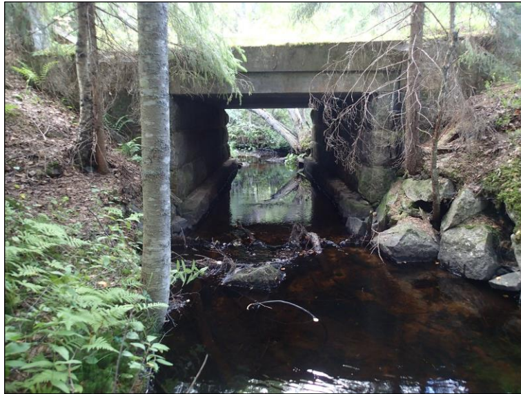
Pieni-Vasemuslammesta Säynätjärveen johtavan puron yli tehty silta. Siinä on betonikansi ja arkut isoista lohkokivistä. Tyyli viittaa 1900-luvulla rakennettuun siltaan.
