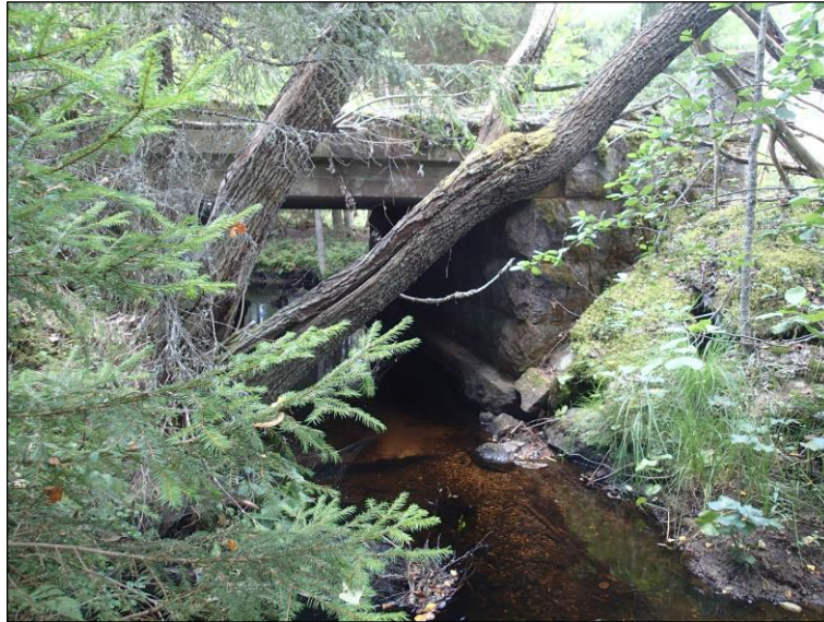
Pieni-Vasemuslammesta Säynätjärveen johtavan puron yli tehty silta. Siinä on betonikansi ja arkut isoista lohkokivistä. Tyyli viittaa 1900-luvulla rakennettuun siltaan.
