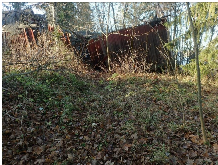
Hyvin sortunutta juoksuhaudaa ulkorakennuksen itäpuolella.
