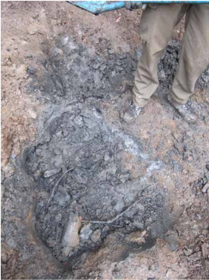
MuTu115021_35. Alue 1. M122:n kaivaus käynnissä. Etelään, 29.5.2015, J. Haarala
