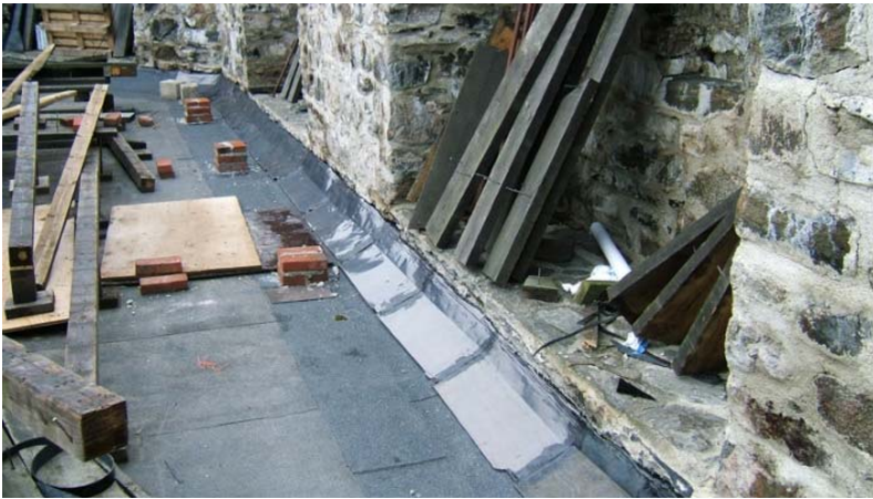
Kuva: Bitumihuopaeristeen päälle asennettiin kuparipelti. Tuomas Vuo 2008, Museovirasto.
