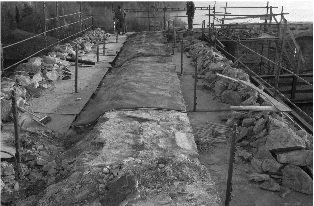
Kuva: Bastionin muurin harjojen vesieristyksen eri vaiheita vuonna 1988. Etualalla puhdistettua ja takana jo emulsiolla sivelyä muurin harjaa. RHO 91775 Heikki Ahtiainen, Museovirasto.
