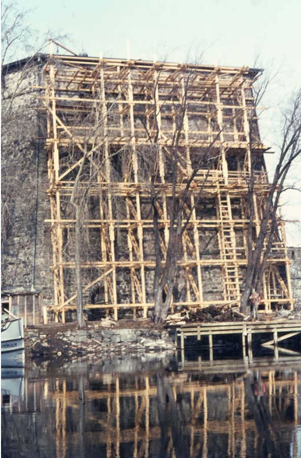
Kuva: Muurin korjauksia varten bastionin eteen rakennettiin puutelineet 1970-luvulla. Museovirasto RHO 3020:160.
