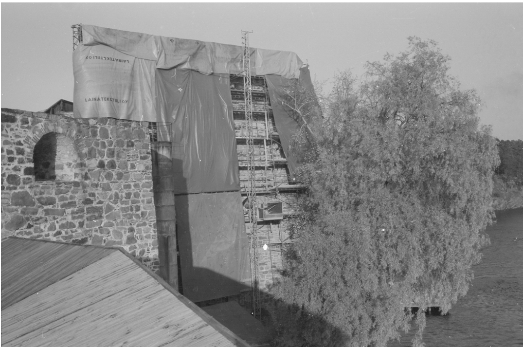
Kuva: Paksun bastionin oikean kyljen eteen oli rakennettu metallitelineet ja korjaustyömaa oli suojattu vuonna 1987. RHO 91727 Heikki Ahtiainen, Museovirasto.
