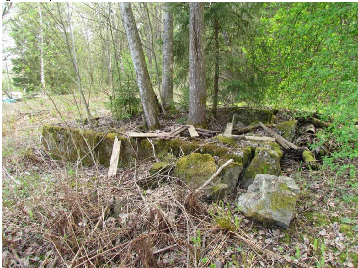
Kuva 20. Rakennuksen perustus B kuvattuna luoteesta. (Kuva: Tampere Vihilahti 2016:5)
