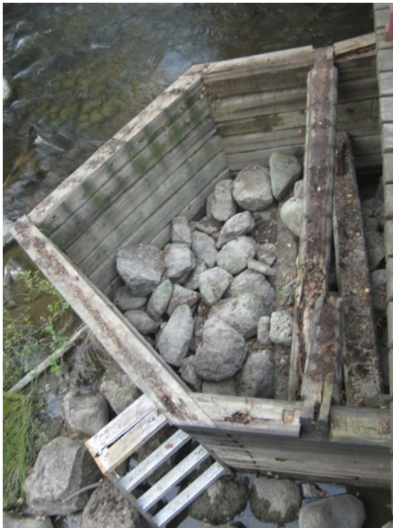
Silta-arkut laudoituksen poiston jälkeen, pohjoispuoli (vas.) ja eteläpuoli (oik.).
