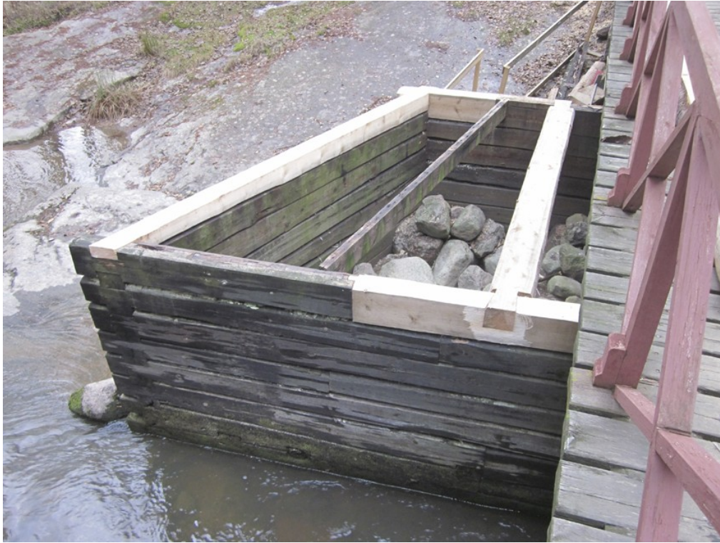
Etelän puoleinen silta-arkku hirsikorjausten jälkeen nähtynä portilta.
