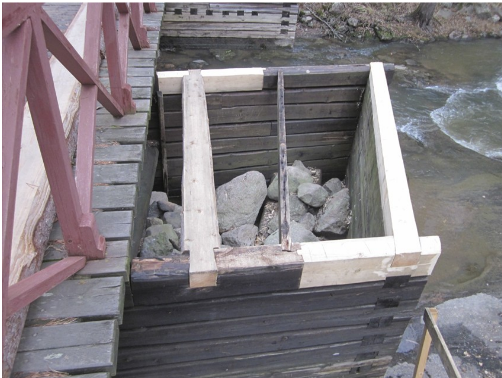
Etelän puoleinen silta-arkku hirsikorjausten jälkeen nähtynä majan puolelta.
