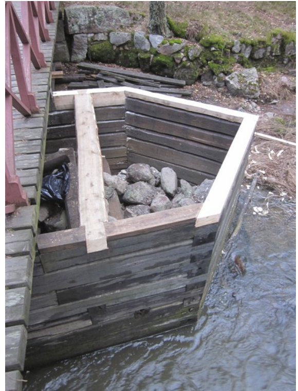
Pohjoisen puoleinen silta-arkku hirsikorjausten jälkeen, nähtynä majan (vas.) ja portin puolelta (oik.).
