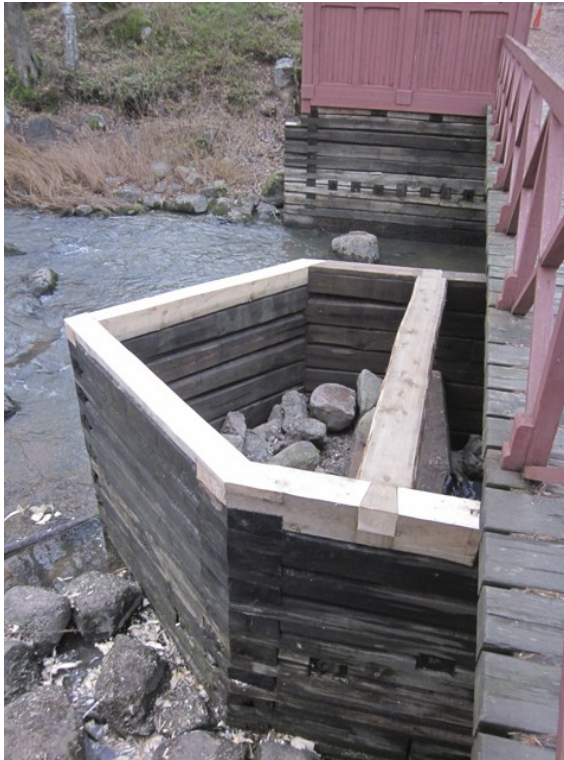
Pohjoisen puoleinen silta-arkku hirsikorjausten jälkeen, nähtynä majan (vas.) ja portin puolelta (oik.).
