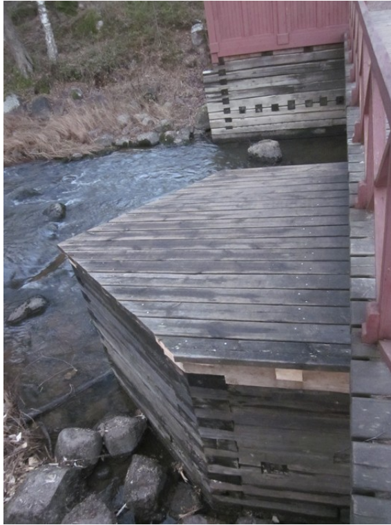
Silta-arkut päällyslautojen asennuksen ja lautojen päätyjen sahauksen jälkeen nähtynä majalta päin, pohjoispuoleinen vasemmalla ja eteläpuoleinen oikealla.
