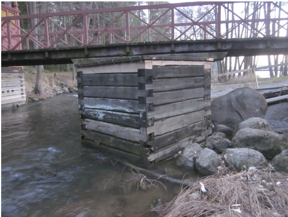
Kuvassa silta-arkku nähtynä pohjoisen puolelta. Alimmat hirsikerrat ovat silminnähden lahonneet, eikä hirsien salvokset pidä arkkukehikon alaosa kasassa.
