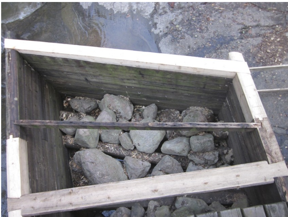
Etelän puoleinen silta-arkku hirsikorjausten jälkeen. Portin puoleinen eli vasen sivuhirsi paikattiin siltaan liittyvästä päästä ja majan puoleisen eli oikean sivun hirsi paikattiin nurkkasalvoksen päästä. Päätyhirsi ja kitapuu uusittiin kokonaan.
