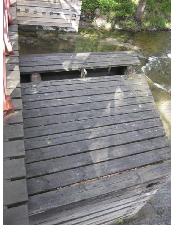
Silta-arkut ennen kunnostusta, pohjoispuolen (vas.) kitapuu oli katkennut ja laudat romahtaneet sisään. Eteläpuolen arkun (oik.) laudoitus puuttui osittain.
