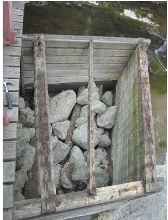
Silta-arkut laudoituksen poiston jälkeen, pohjoispuoli (vas.) ja eteläpuoli (oik.).
