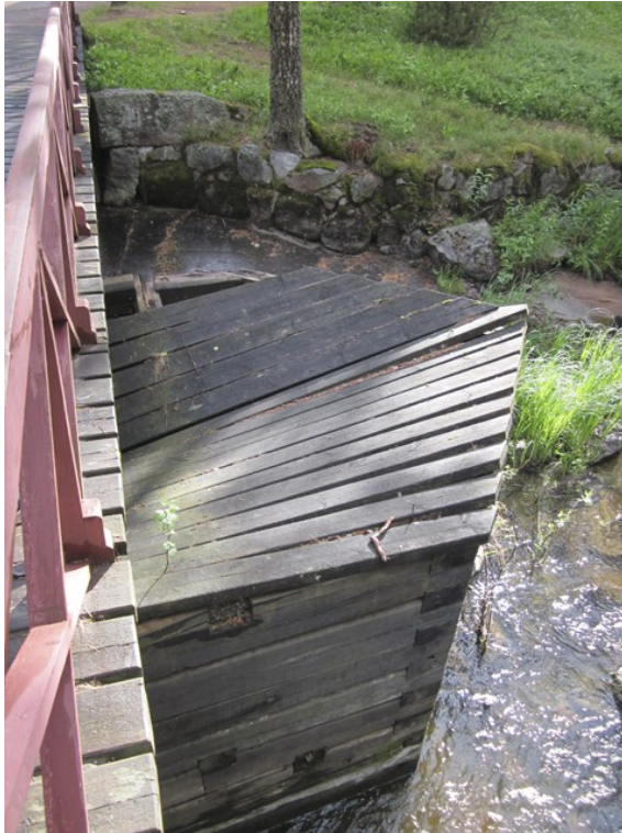
Silta-arkut ennen kunnostusta, pohjoispuolen (vas.) kitapuu oli katkennut ja laudat romahtaneet sisään. Eteläpuolen arkun (oik.) laudoitus puuttui osittain.
