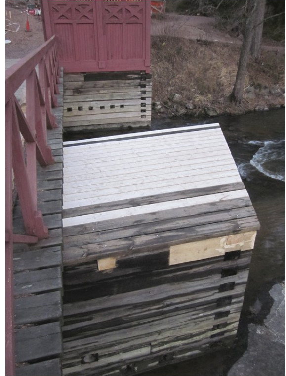
Silta-arkut päällyslautojen asennuksen ja lautojen päätyjen sahauksen jälkeen nähtynä majalta päin, pohjoispuoleinen vasemmalla ja eteläpuoleinen oikealla.
